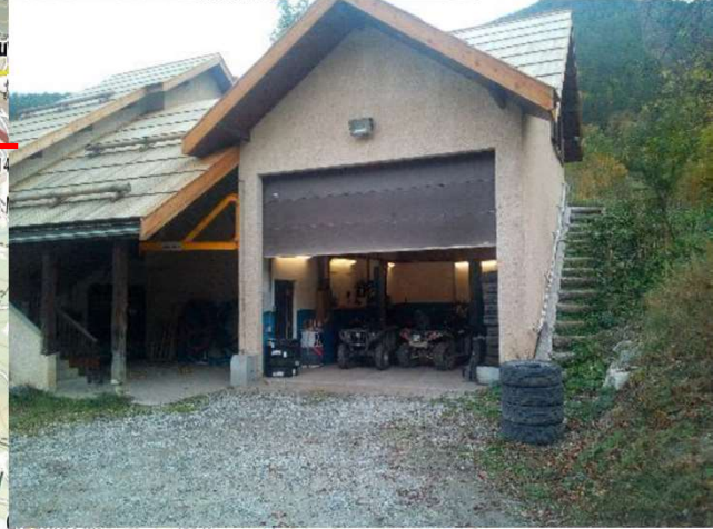
Salle des machines Fréjus
