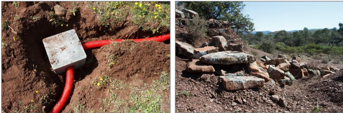
Création de gîtes à Lézard ocellé pouvant être réalisés en pierres sèches avec ou sans gaine PVC et regard béton © Joseph CELSE
