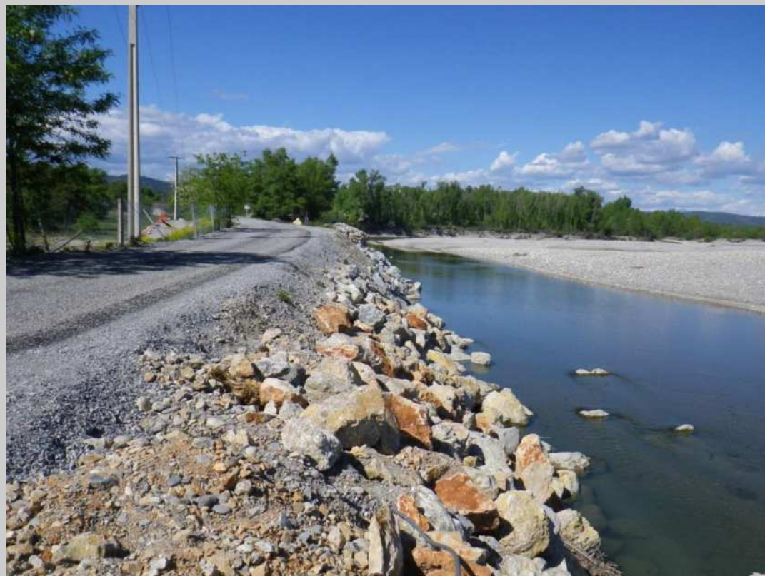
1. Vue de la berge enrochée et de la route
