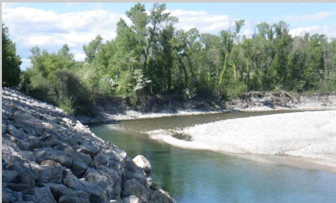
2. Vue du lit d'étiage au niveau du coude en amont
