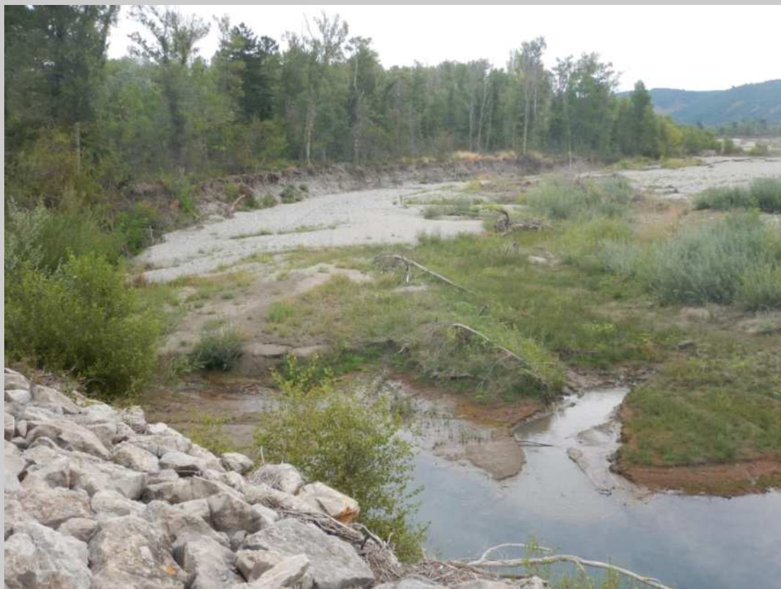
2. Vue du lit en amont de la protection lit d'étéage disparu
