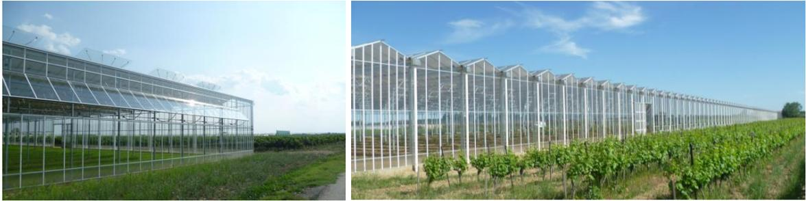
Figure 17 : Ouvrants en façade Nord et vue façade Est - Source : Reden Solar
