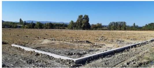
Figure 18 : Fondations béton extérieures (longrine) - Source : Reden Solar
