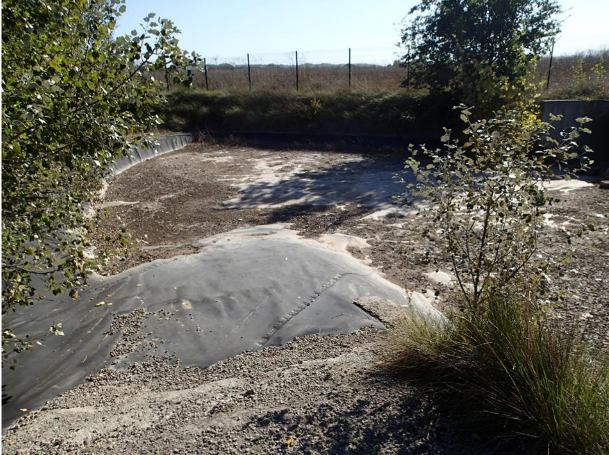
Figure 20 Photographie d'une vue sur le bassin de rétention sur l'aire d'étude (source : ECOTONIA)
