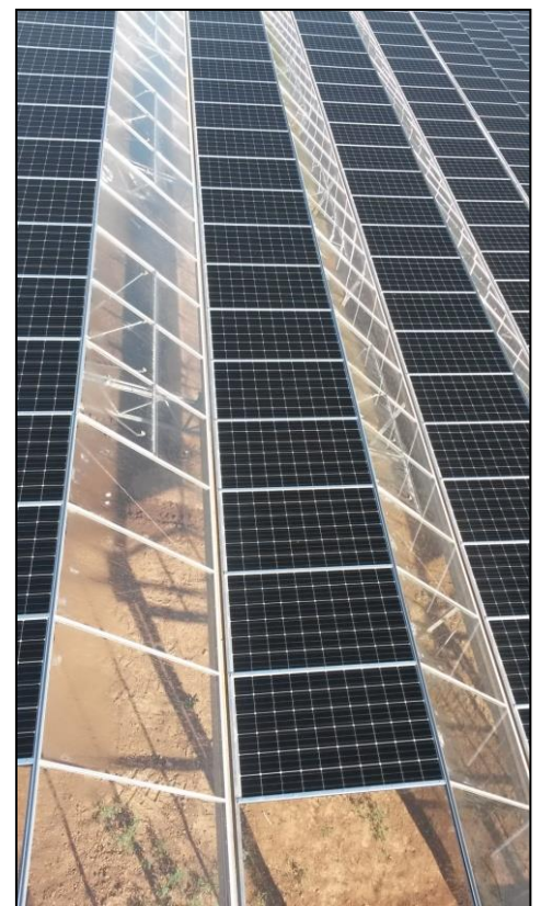
Pans nord vitrés Pans sud équipés de panneaux photovoltaïques
