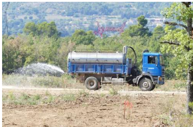
Humidification des pistes d'accès à l'aide d'un camion-citerne
