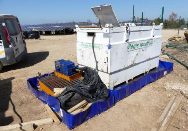
Tous les contenants de produits polluants doivent être placés sur des bacs de rétention ou sur une plateforme étanche adaptée - DRYOPTERIS, 2017
