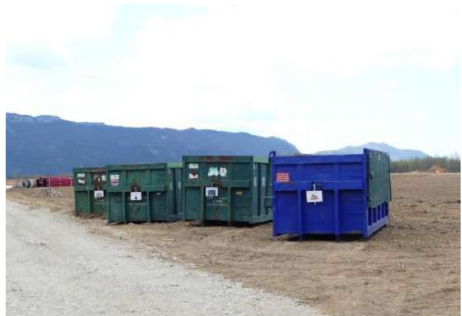
Bennes à déchets sur un chantier de parc photovoltaïque DRYOPTERIS, 2017
