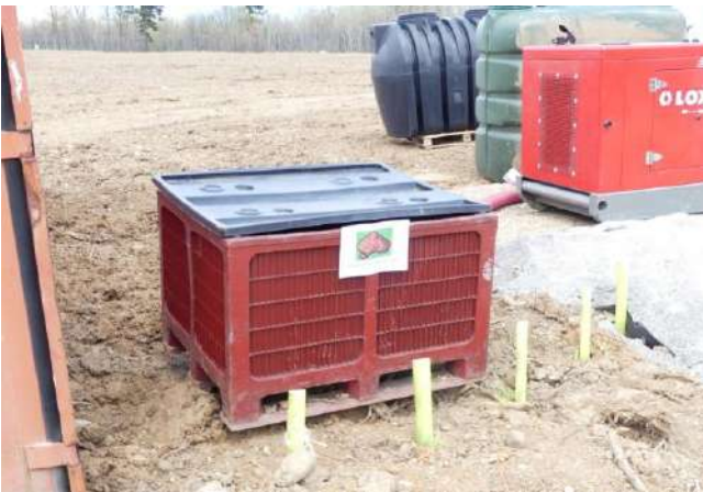
Stockage des terres et gravats pollués avant envoi vers un centre de traitement DRYOPTERIS, 2017
