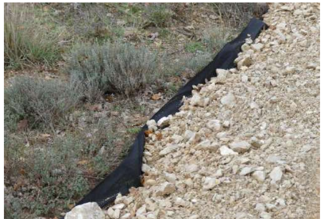
Géotextile placé sous une surface empierrée temporairement DRYOPTERIS, 2017
