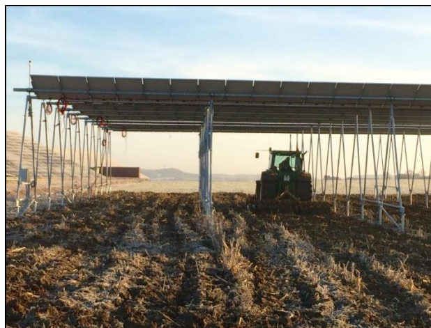
Figure 10 – Prototype standard proposé initialement par le structuriste, en implantation Est-Ouest et avec une structure bipieds
