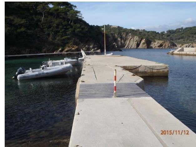
Môle central (barge coulée) - Deux vues depuis le terre-plein (à gauche) et une vue depuis le quai derrière la digue (à droite)
