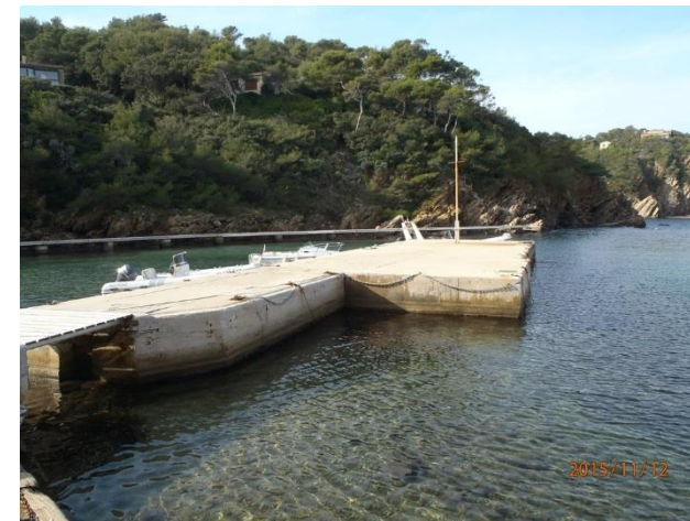
Môle central (barge coulée) - Deux vues depuis le terre-plein (à gauche) et une vue depuis le quai derrière la digue (à droite)
