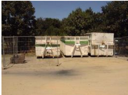
Figure 54 : Exemple de bennes destinées à accueillir les déchets de chantier
