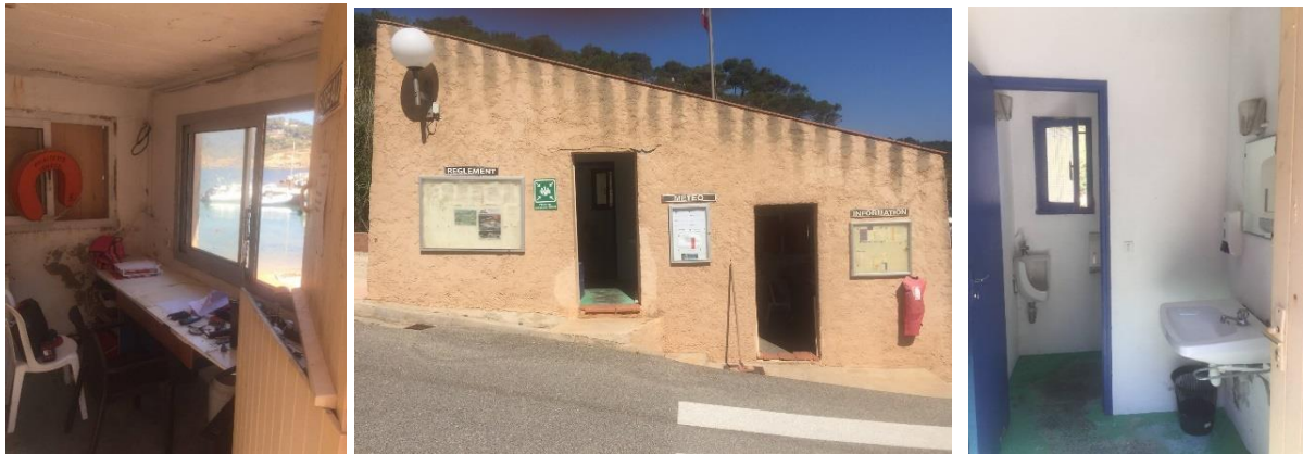
Figure 27 : État des lieux du bâtiment existant de la capitainerie
