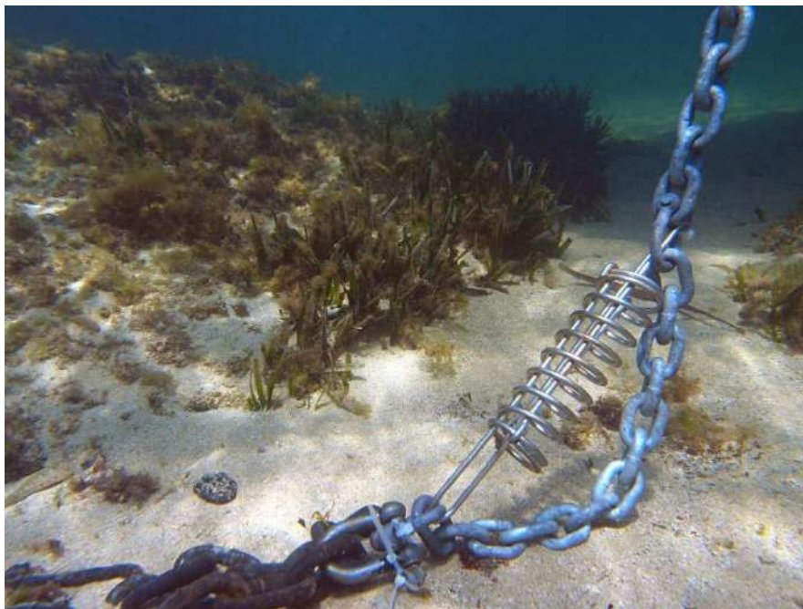
Planche n°46 – Chaîne d'amarrage neuve à l'extrémité d'un ponton
