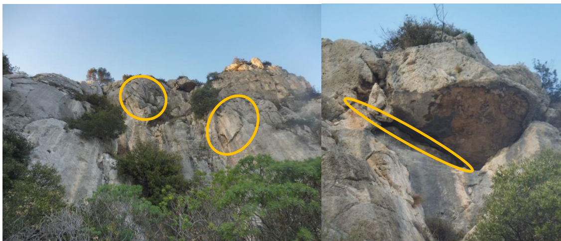
Figure 14 : Secteurs et fissures favorables aux chiroptères
