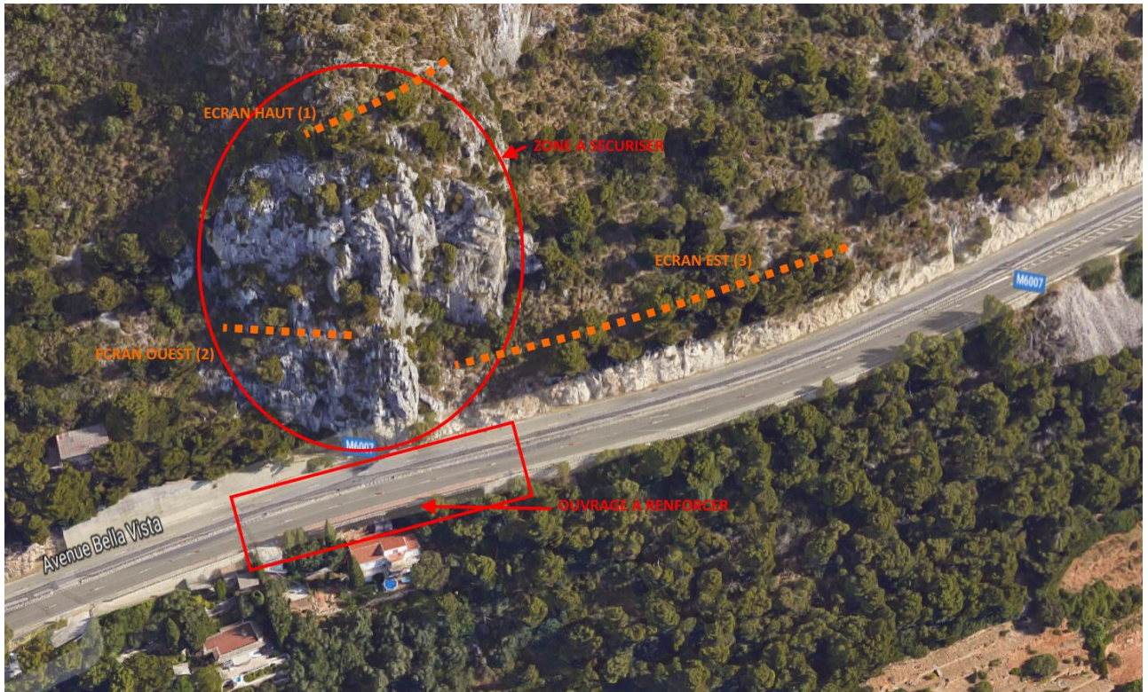
Zoom sur les différentes zones de travaux
