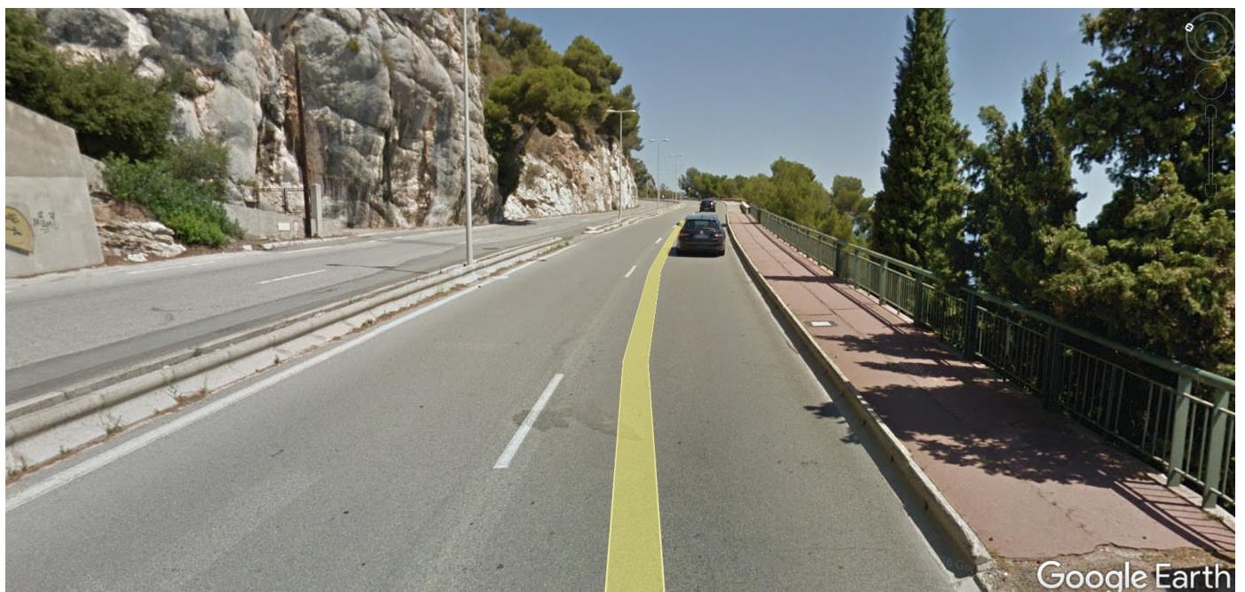
Ouvrage concerné par le renforcement
