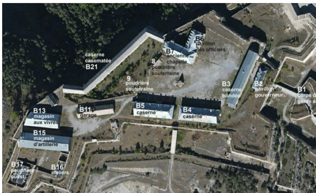
Localisation des bâtiments actuels du site
