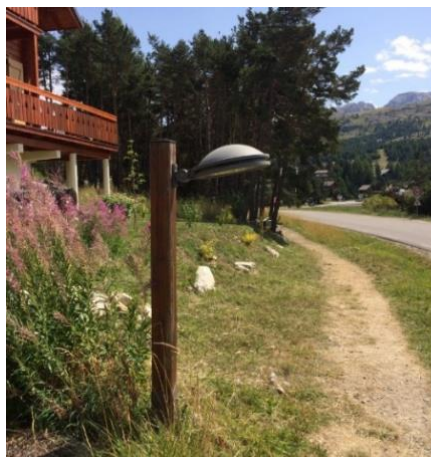
Exemple de lampadaire présentant un faible impact vis-à-vis les chiroptères
