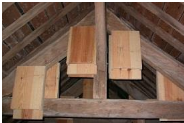
Exemple de gîtes artificiels inamovibles sous charpente
