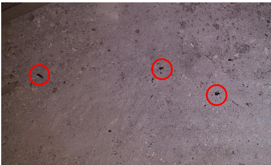
Figure 3: Guano observé dans le bâtiment 3 (© M. DAVAL - GCP)
