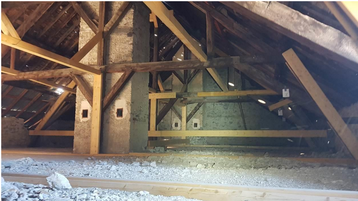
Figure 8: Comble favorable au gîte des Chiroptères dans le bâtiment 5 (© M. DAVAL - GCP)
