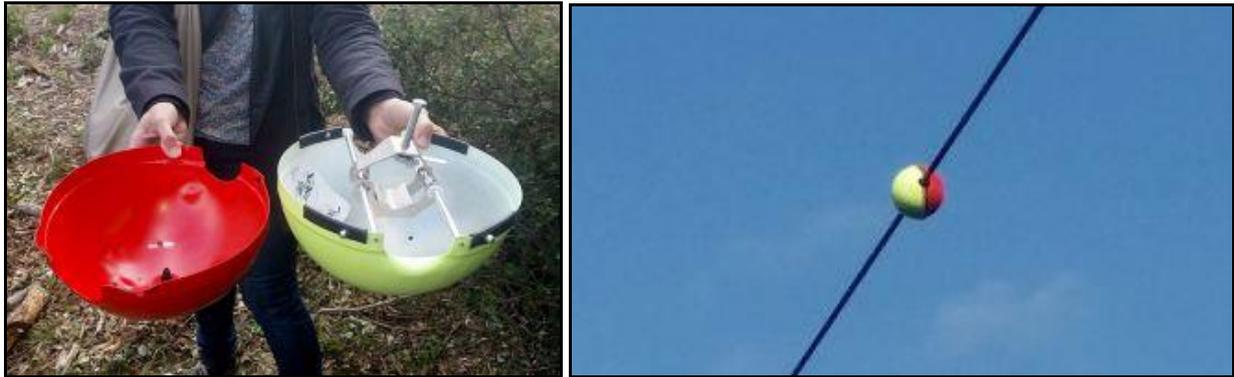
Figure 47 : Avisphères installées sur une ligne électrique par la RTE dans le massif des Alpilles pour la protection des oiseaux
