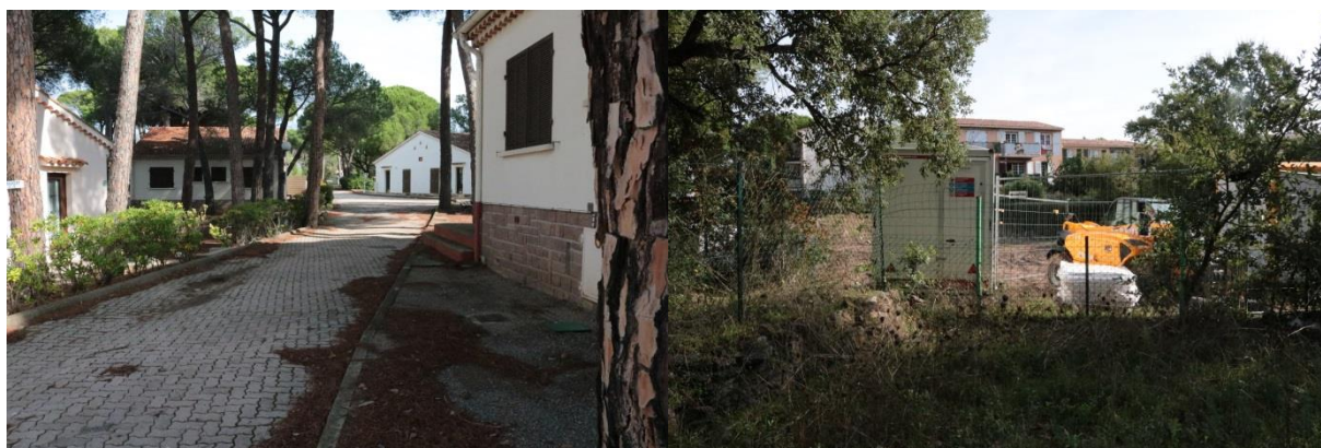
Photo 9 : Bâti et espaces de jeu présents dans le secteur d'étude, ainsi que vue sur le chantier en cours au nord-est du secteur d'étude (FL, octobre 2018)
