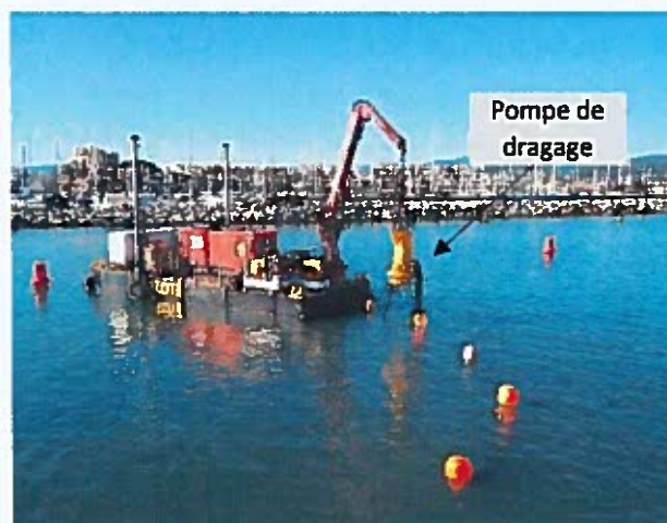
Atelier de dragage hydraulique opérant à Port Grimaud
