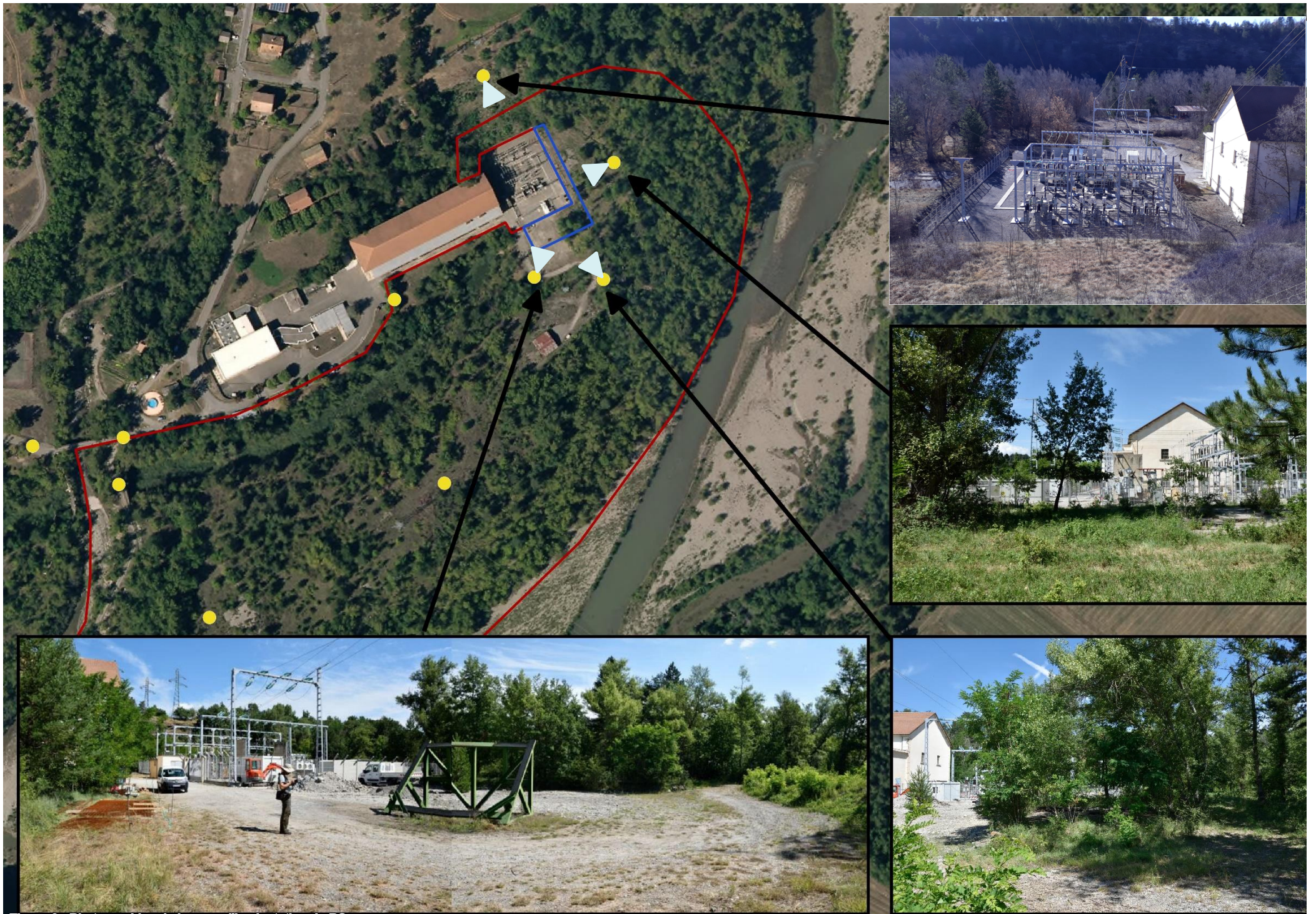
Figure 6 : Photographes de la zone d'implantation du PS
