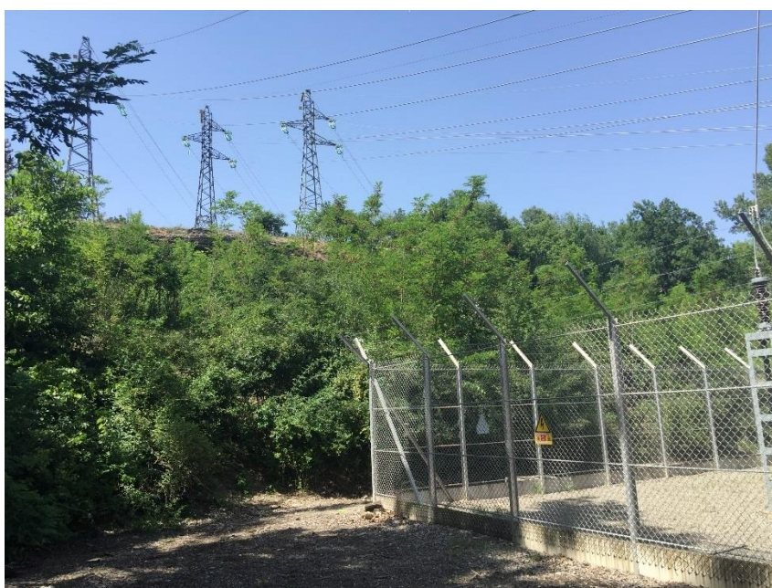
Photographie de la forte dénivellation à l'arrière du site
