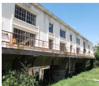
Ancienne centrale hydraulique présentant des galeries en dessous
