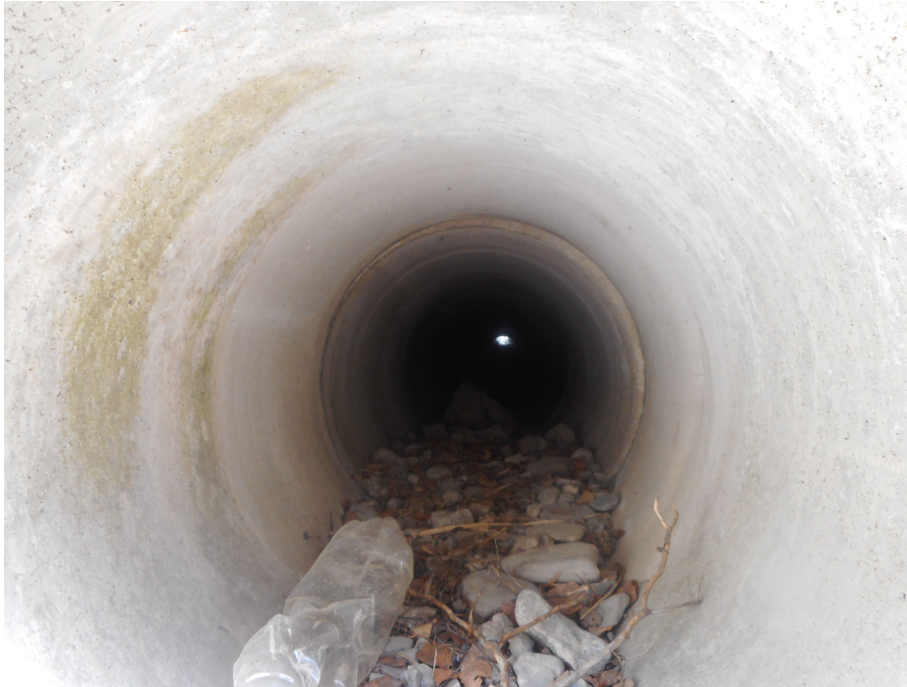
Buse DN 500 sous la D908 vue de l'amont
