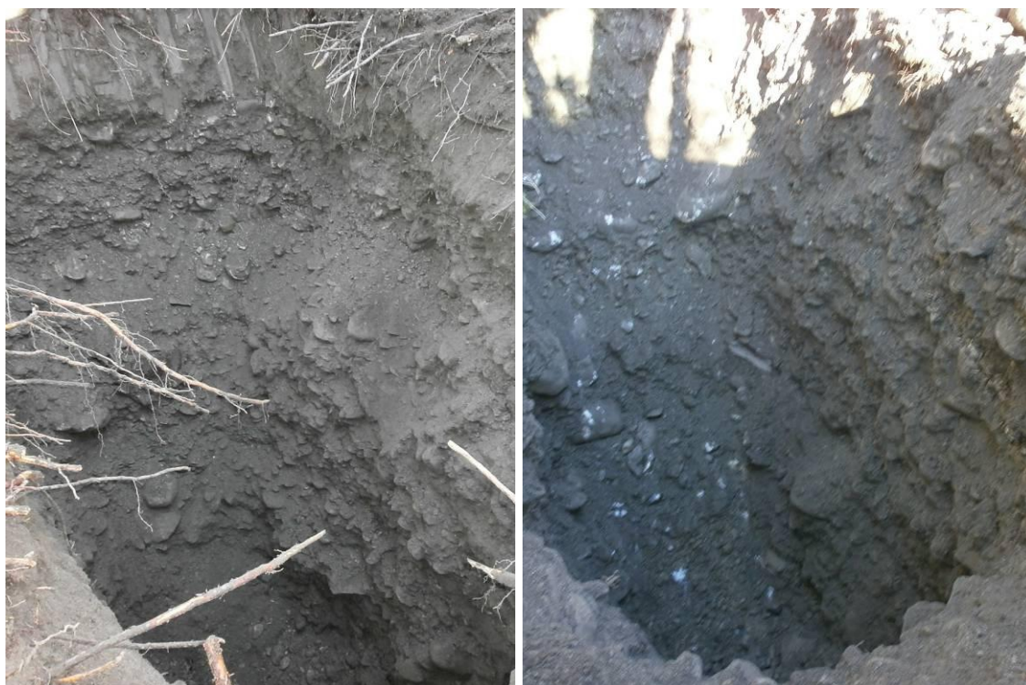
Photos n° 6 et n° 7 : sondages S1 et S2
