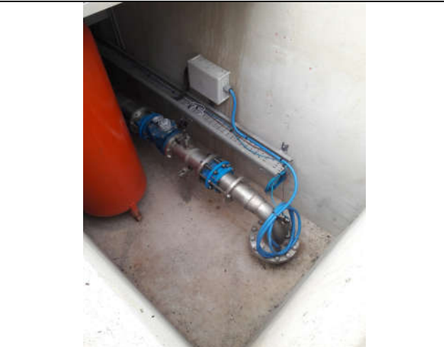
Vue intérieure de la chambre de tête de forage
