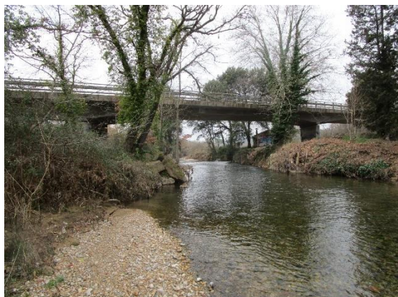
Photographie 8 : Secteur 7 – pont de la RD54 -- Prise de vue 20/02/2018
