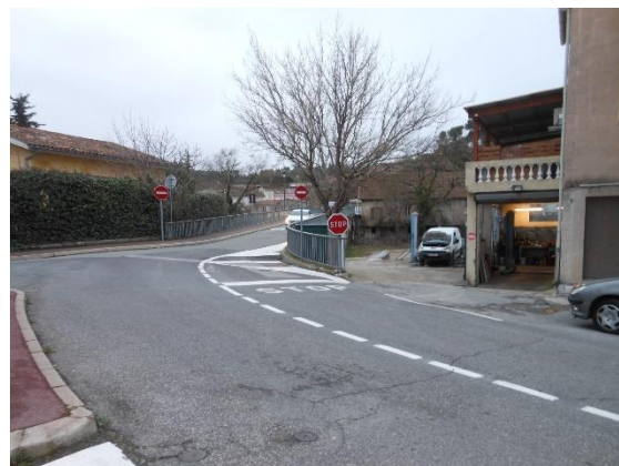
Photographie 7 : Secteur 6 – Pont des écoles - Prise de vue 06/02/2018
