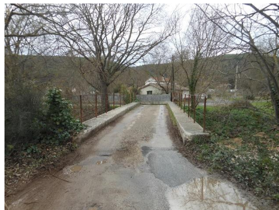
Photographie 5 : Secteur 4 – Pont du chemin des berges – Prise de vue 06/02/2018
