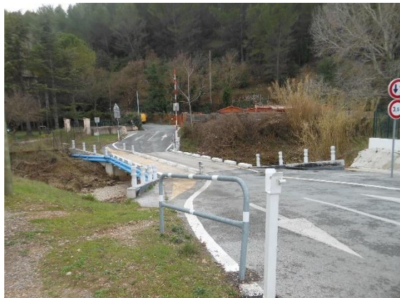
Photographie 4 : Secteur 3 – Pont submersibles des Incapis – Prise de vue 06/02/2018
