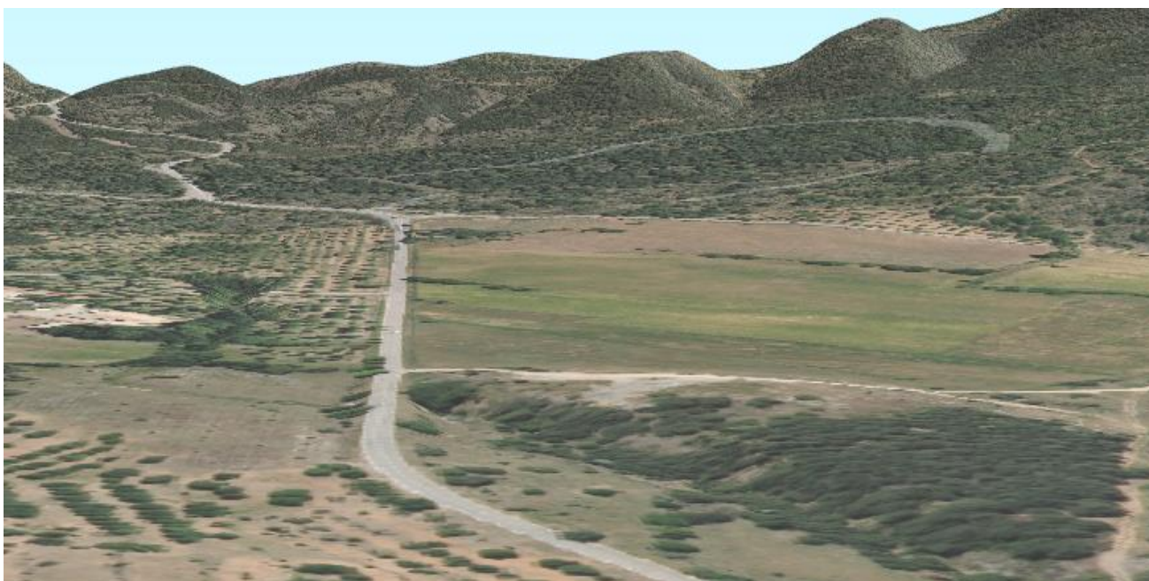
Vue du pare-feu depuis la D957 au Nord : Majastre
