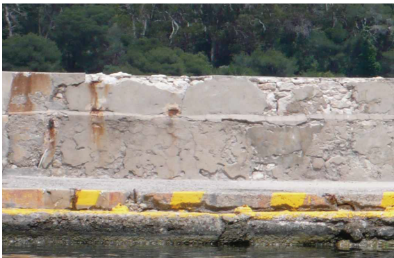
Fig. C•64 - Mur-abri en maçonnerie de moellons (© CPA)
