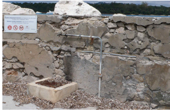
Fig. C•63 - Point d'eau à usage des plaisanciers (© CPA)
