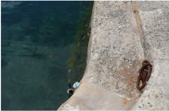
Fig. C•62 - Organeau et alimentation en eau du quai (© CPA)
