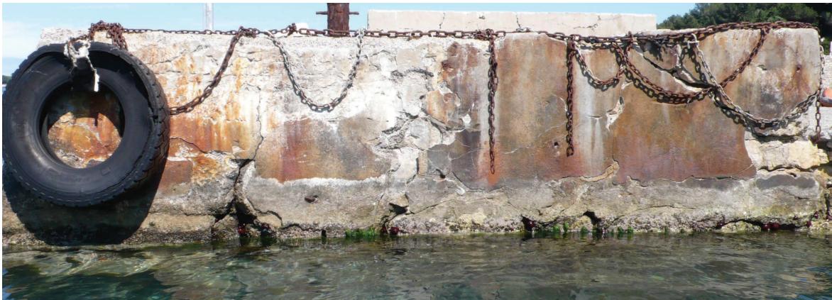
Fig. C•68 - Parement du musoir dans la passe d'entrée (© CPA)
