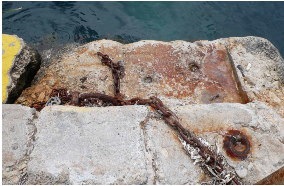
Fig. C•57 - Angle sud-ouest du quai (© CPA)
