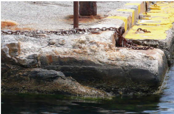
Fig. C•59 - Bloc sud-ouest démaigri (© CPA)
