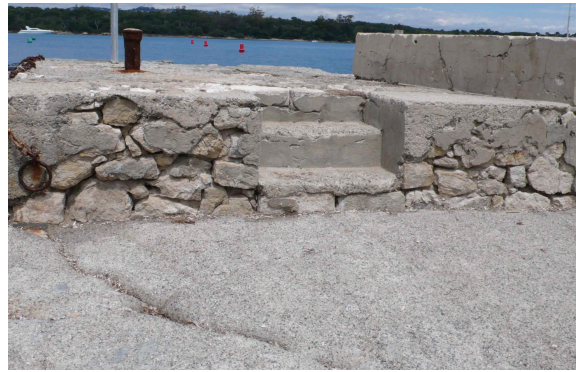
Fig. C•58 - Fissure transversale oblique (© CPA)
