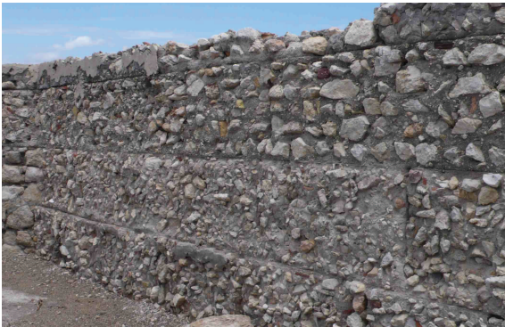
Fig. C•50 - Mur en éléments préfabriqués (© CPA)
