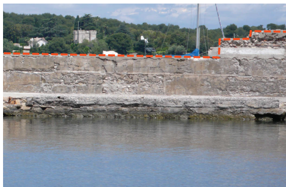
Fig. C•55 - Mur-abri, réduction en hauteur (© CPA)
