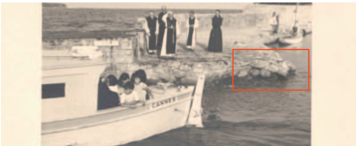
Fig. C•61 - Désordre au droit de l'angle sud-ouest du quai en 1949 (Source : Monastère de St-Honorat)
