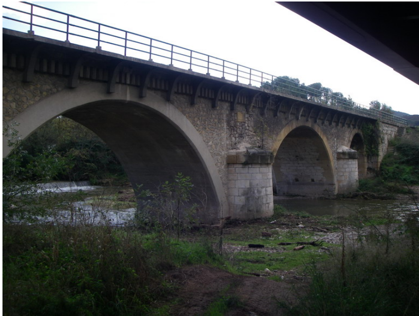
Figure 3-7 : Pont de l'ancienne RN 113
