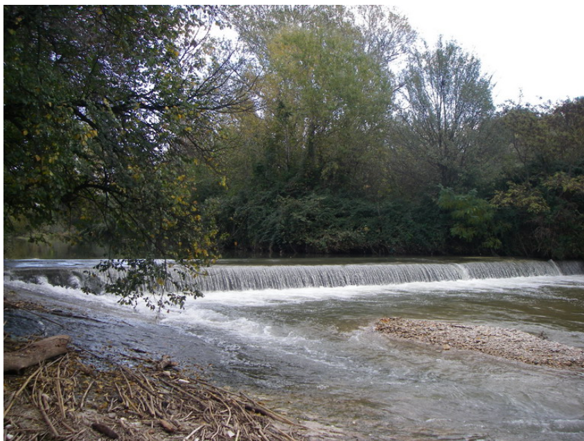
Figure 3-6 : Seuil en amont du Pont de la Fare
