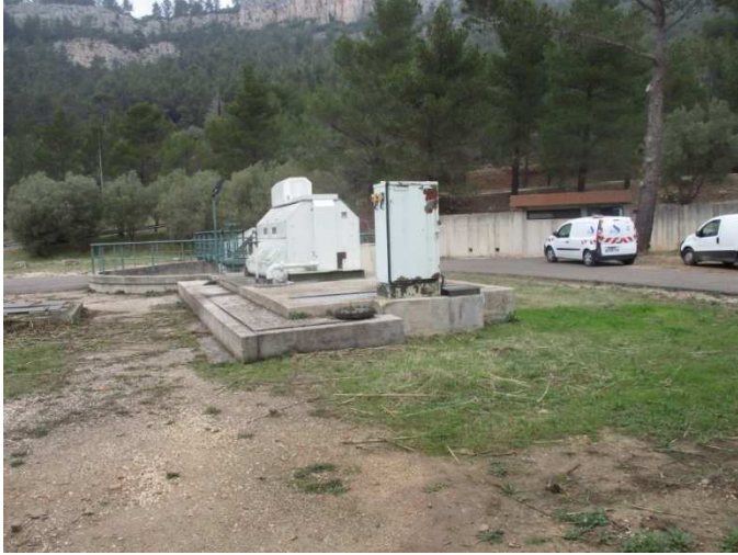
Photo (5) Vue vers ouest - Bassin de décantation / bassin tampon
