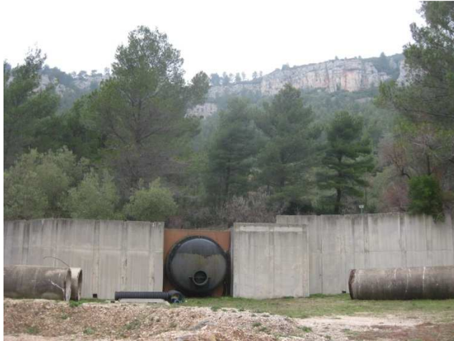
Photo (2) Vue vers sud ouest : brise charge
