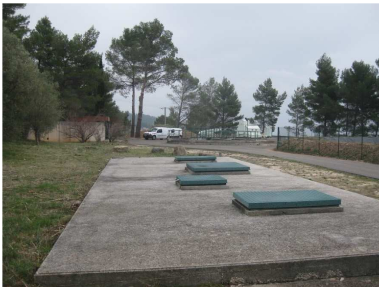
Photo (4) Vue vers nord-ouest- Appareillage du brise charge
