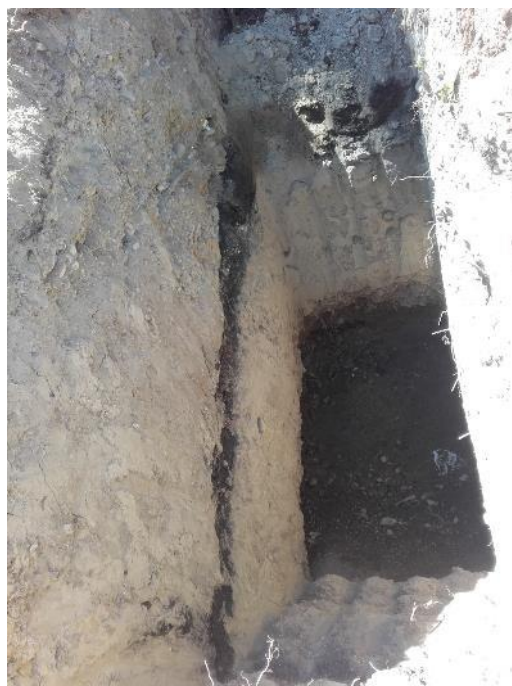
Photo 2 : Fouille sud, maintenue ouverte durant les travaux
