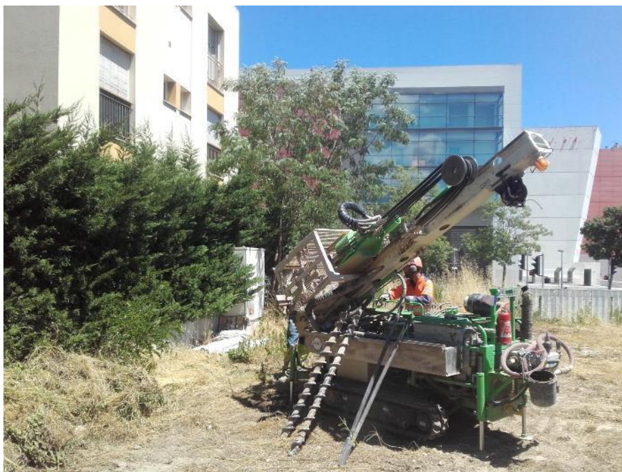
Photo 24 : Réalisation du sondage S2E-20
