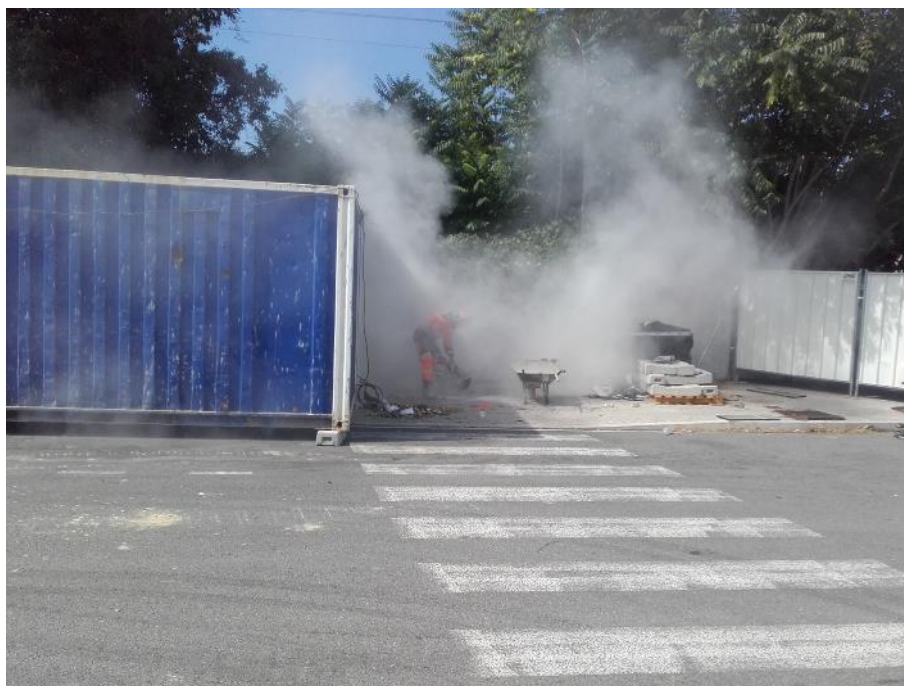
Photo 8 : Perçage de la dalle au niveau du piézomètre S2E-7
