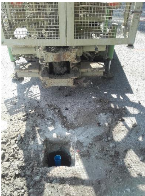
Photo 12 : Equipement du piézomètre S2E-15 avant réalisation de la tête de protection
