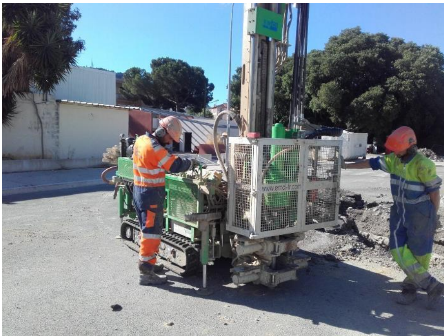
Photo 17 : Réalisation du sondage S2E-3
