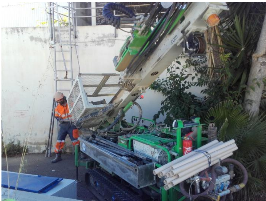
Photo 19 : Réalisation du sondage S2E-4
