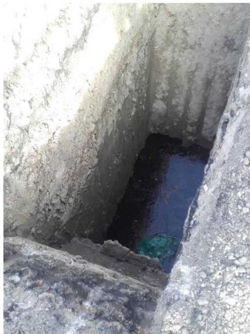
Photo 1 : Fouille (FNSE) maintenue ouverte durant les travaux
