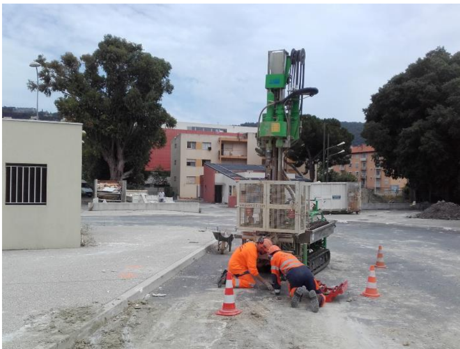
Photo 3 : Réalisation du piézomètre S2E-11
