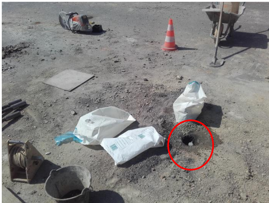
Photo 7 : Finalisation du piézair S2E-10 avant réalisation de la tête de protection
