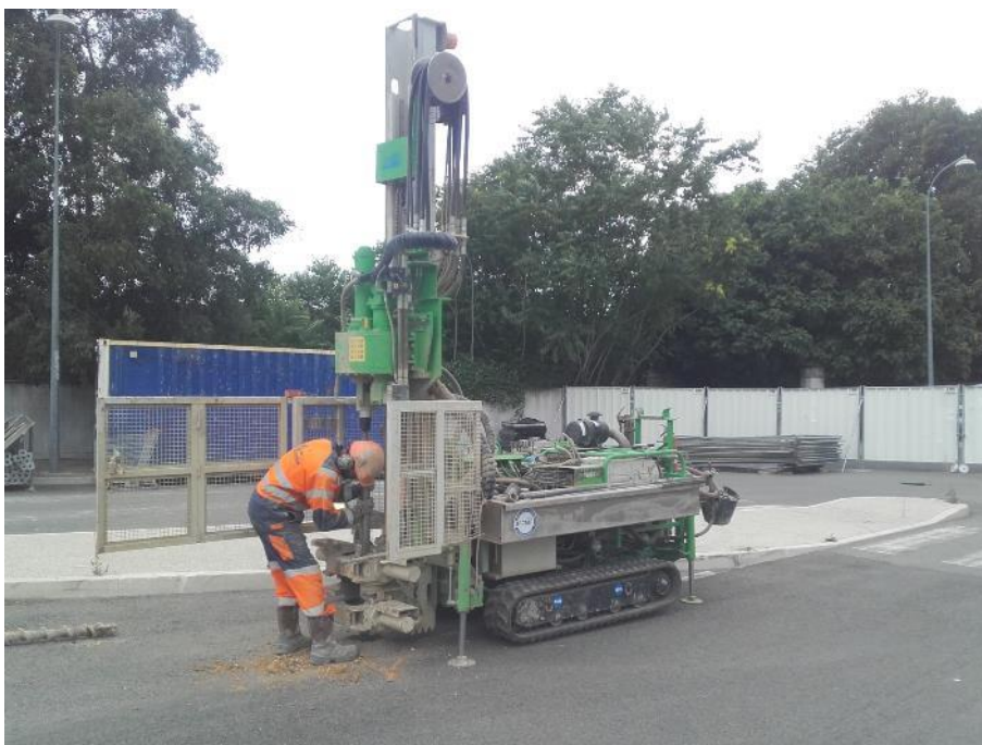
Photo 14 : Réalisation du sondage S2E-1
