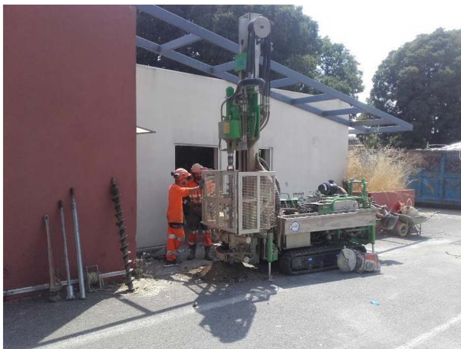
Photo 10 : Réalisation du sondage S2E-16
