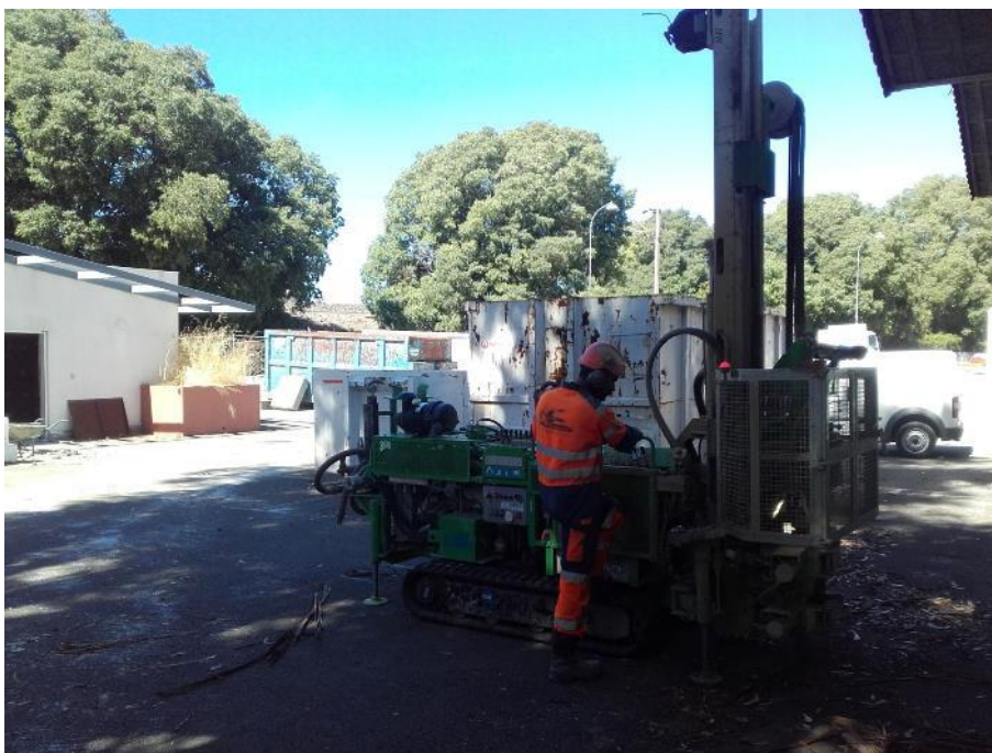
Photo 22 : Réalisation du sondage S2E-5
