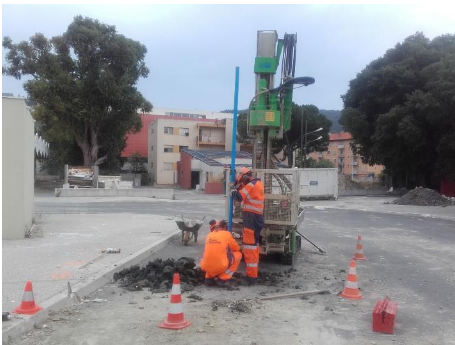
Photo 4 : Equipement du piézomètre S2E-11
