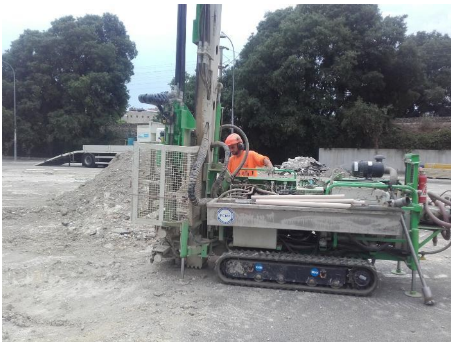
Photo 13 : Réalisation du sondage S2E-2
