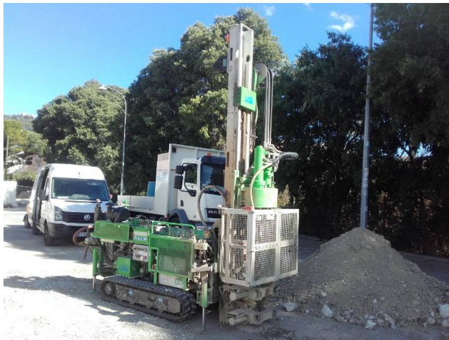
Photo 25 : Réalisation du sondage S2E-9
