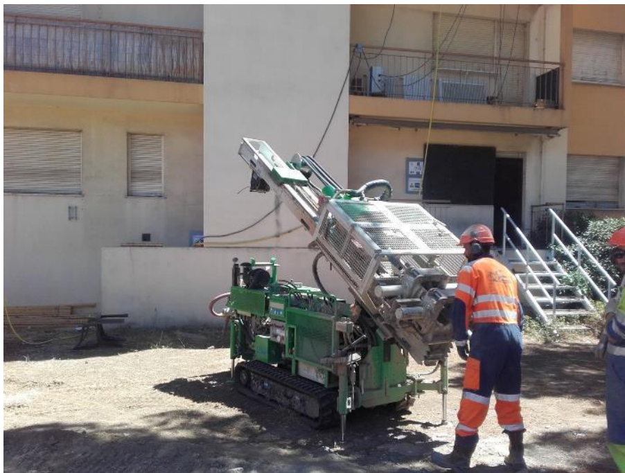
Photo 23 : Réalisation du sondage S2E-19
