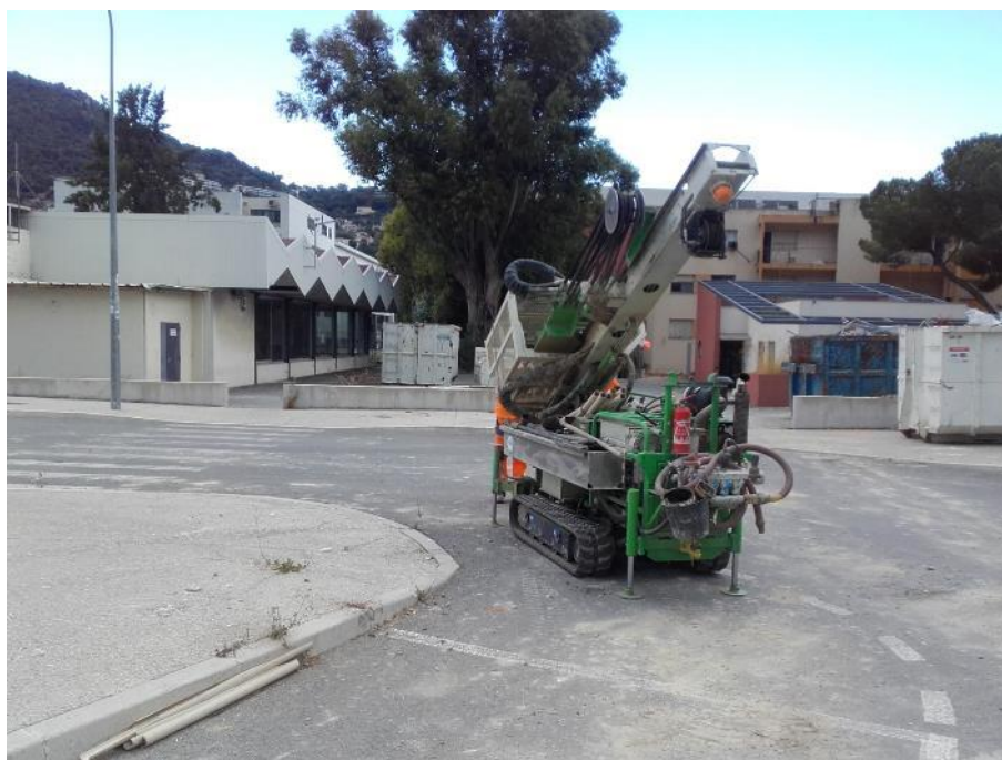
Photo 16 : Réalisation du sondage S2E-13
