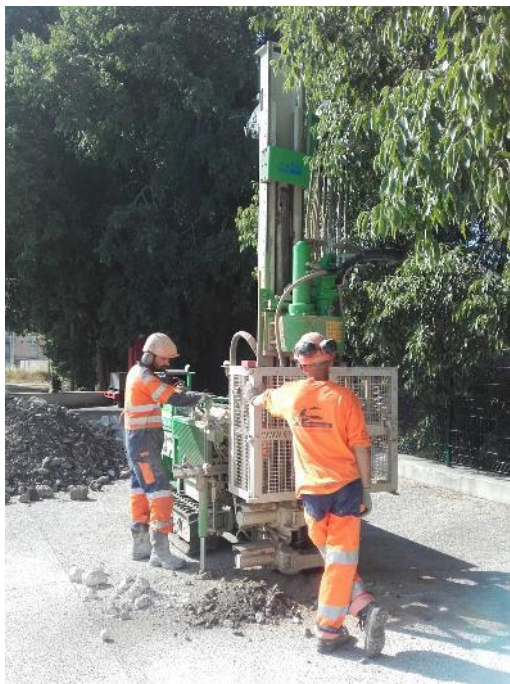
Photo 11 : Réalisation du piézomètre S2E-15
