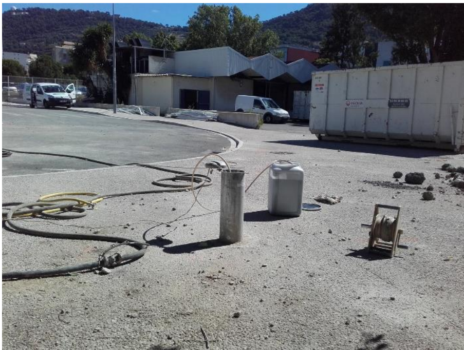
Photo 21 : Développement du piézomètre S2E-15 en parallèle des investigations
