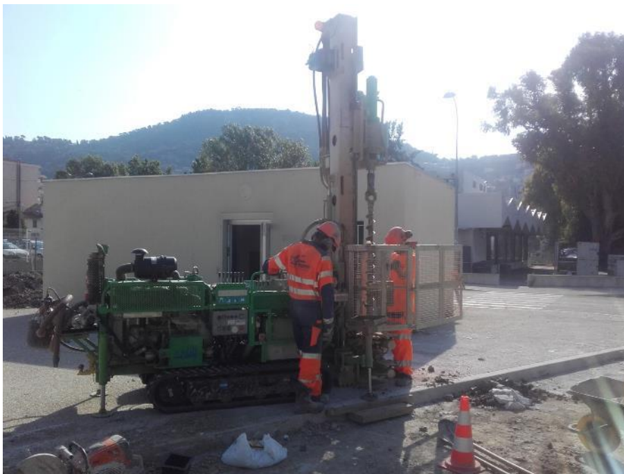
Photo 5 : Tentative pour la réalisation du piézair S2E-10
