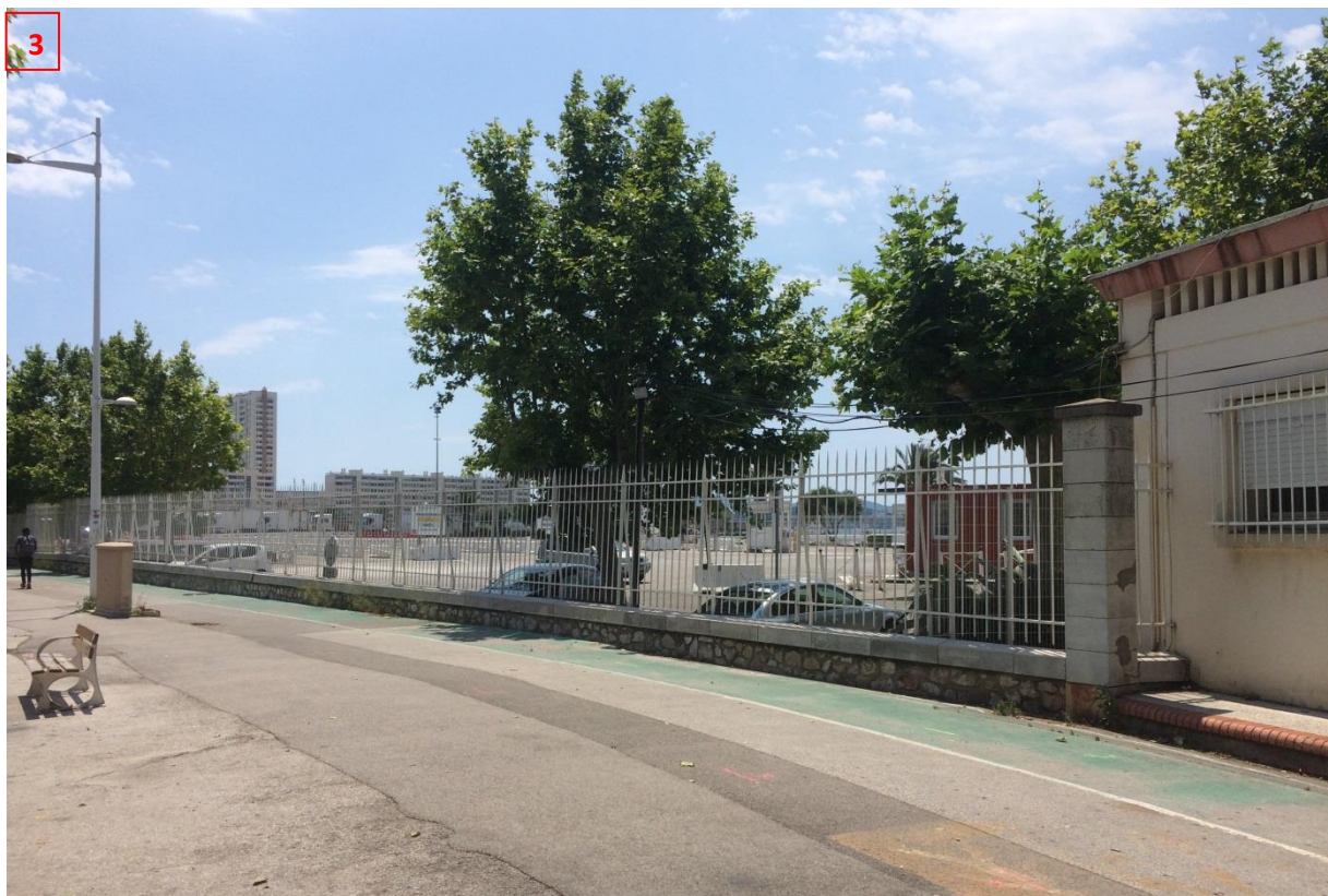
Vue depuis l'avenue de l'Infanterie de Marine / amélioration de la perception
