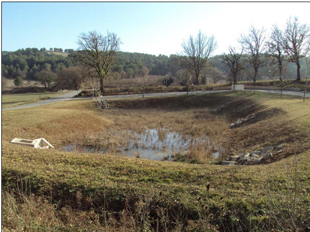
Exemple de bassin de rétention paysager, enherbé (cliché : PGC, 2011).
