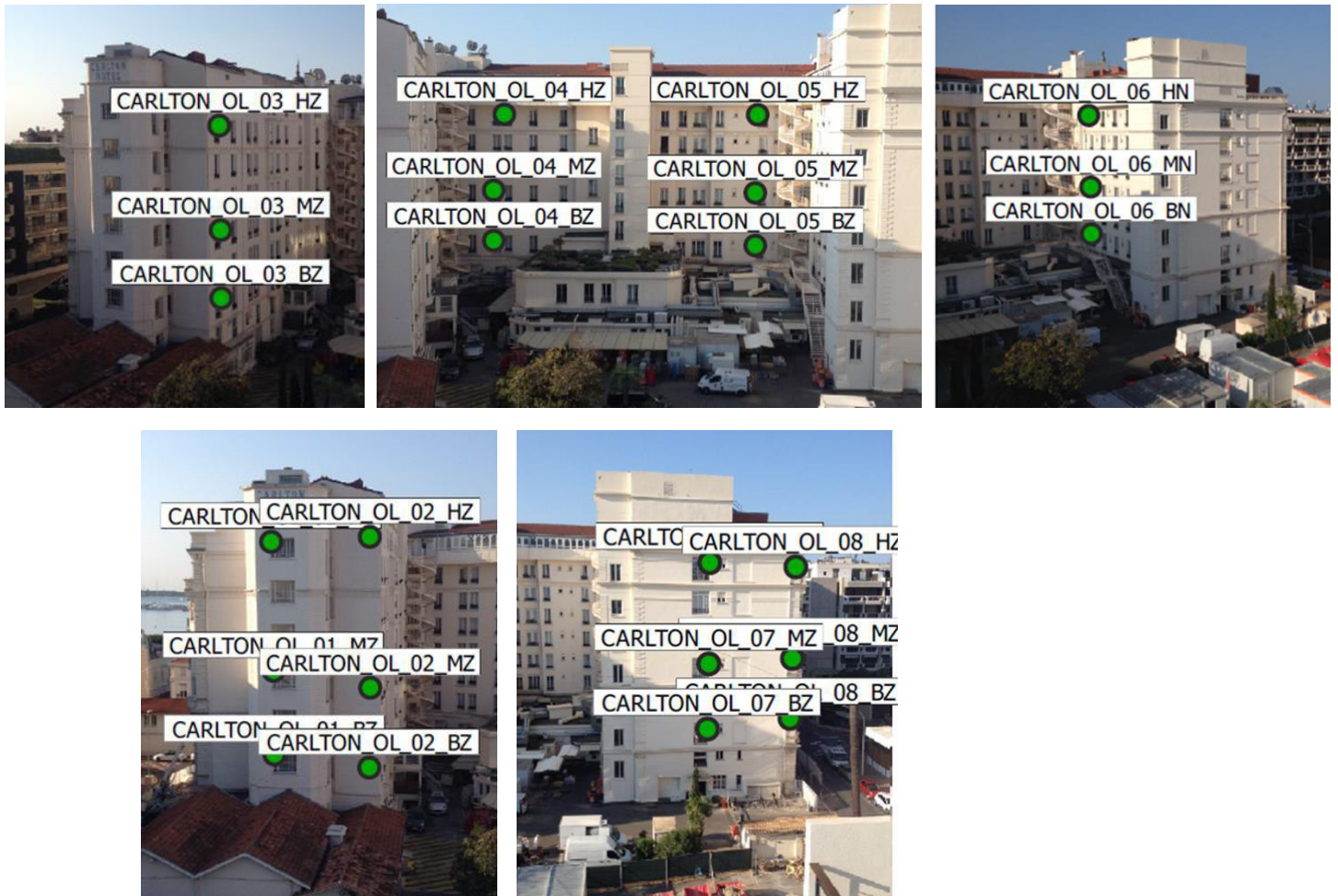
Figure 4 : Localisation des cibles prismes sur la Old Lady (extrait rapport SOLDATA)
