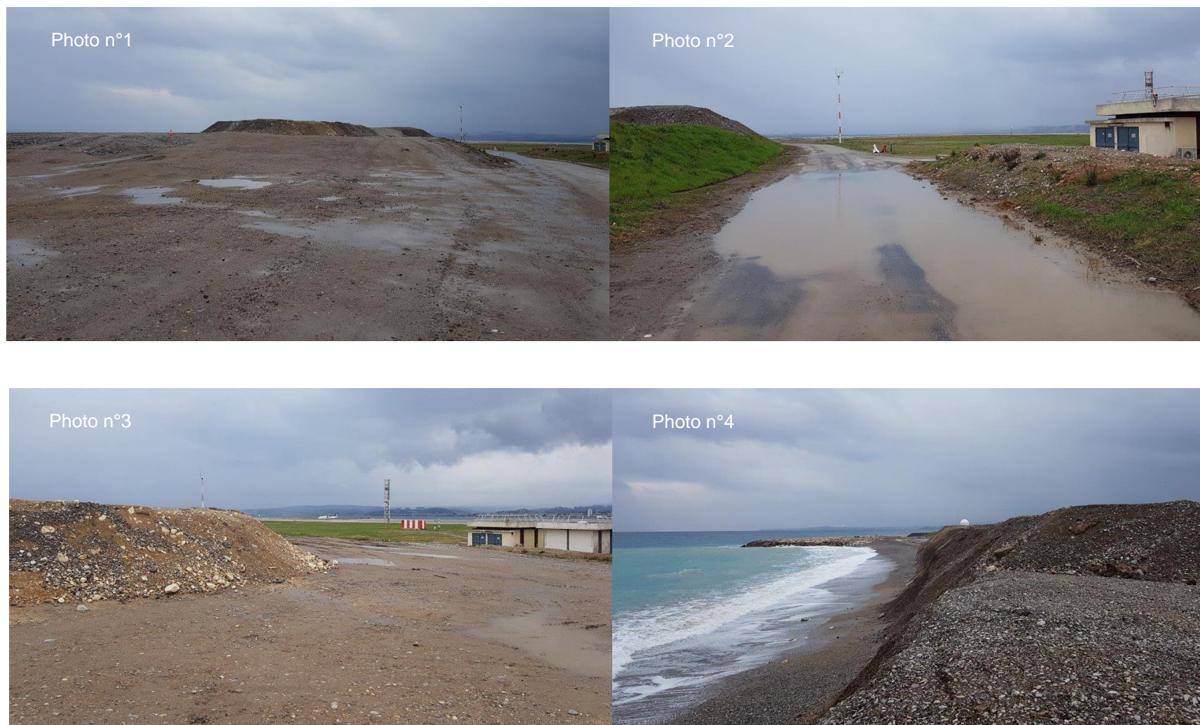
Figure 13 : Photos n°1 à 4 – butte renforcée (Aéroport Nice Côte d'Azur – février 2018)
