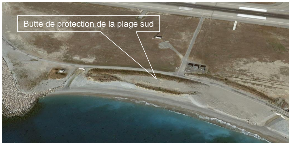
Figure 11 : Butte de protection sur la plage sud de la plateforme aéroportuaire (Google Earth Pro)
