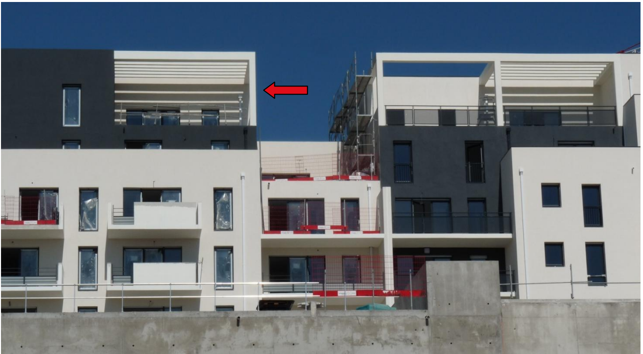
Espace entre les étages du bâtiment © M. Gendrot
