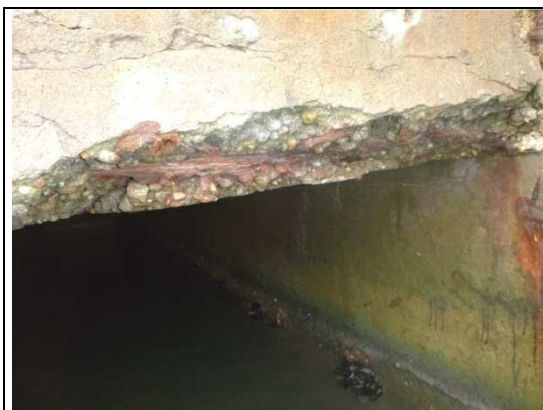
Au niveau de VI4 – Eclat de béton avec acier apparent très corrodé
