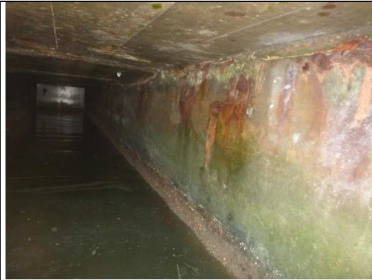
Au niveau de V7/V8 – Couleurs d'oxyde sur voile
