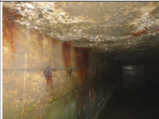
Au niveau de V5/V6 – Ségrégations et coulures d'oxyde
