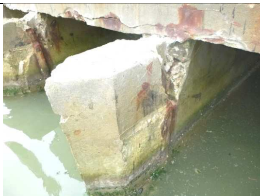
Au niveau de VI2/VI3 – Eclats de béton, fissures et aciers apparents corrodés
