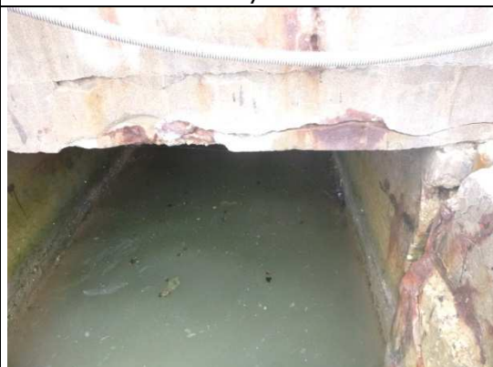
Au niveau de VII/VI2 – Amorce d'éclat et traces de corrosion
