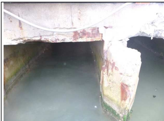
Au niveau de V9/V10 – Désordres multiples
