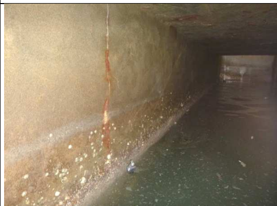
Au niveau de VI2/VI3 – Fissure verticale avec coulure d'oxyde sur voile
