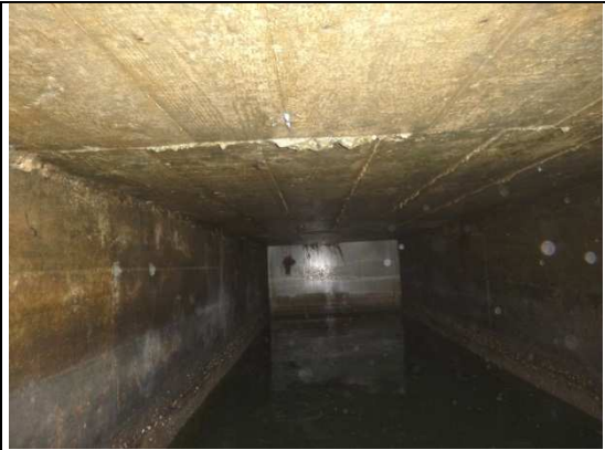
Au niveau de V7/V8 – Vue de l'intrados
