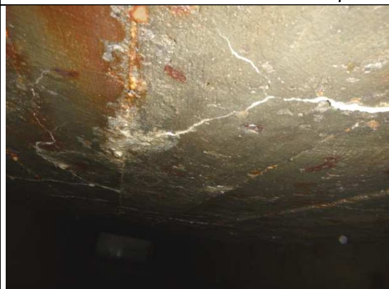
Au niveau de V9/V10 – Fissures calcifiées en sous-face
