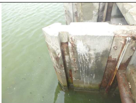
Au niveau de V7/V8 – Corrosion des pièces métalliques et amorces d'éclat sur voile
