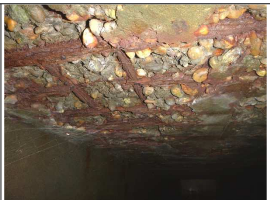
Au niveau de VI4 – Eclat de béton avec aciers apparents très corrodés
