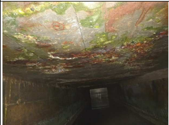
Au niveau de V4/V5 – Ségrégations, coulures d'oxyde et traces verdâtres
