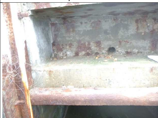
Au niveau de V7/V8 – Traces de corrosion sur parement
