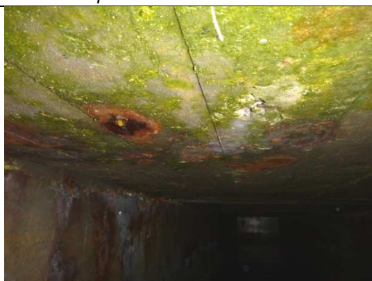
Au niveau de V7/V8 – Traces de corrosion et traces verdâtres
