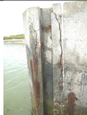
Au niveau de V5/V6 – Amorces d'éclat en tête de voile
