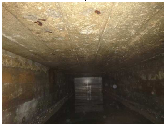
Au niveau de V4/V5 – Vue de l'intrados
