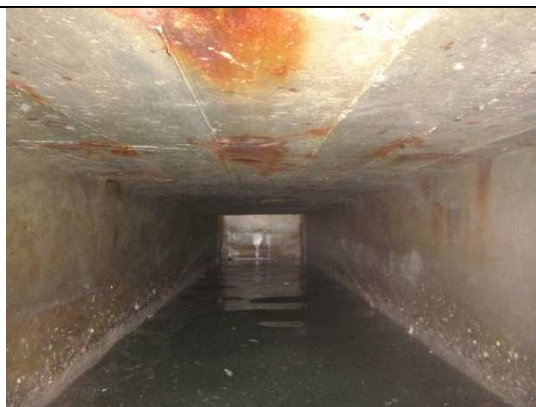
Au niveau de VI2/VI3 – Traces d'oxydation
