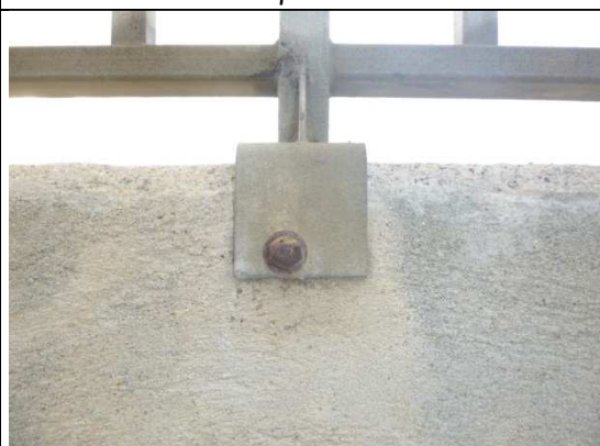
Au niveau de V7/V8 – Corrosion des boulons de fixation
