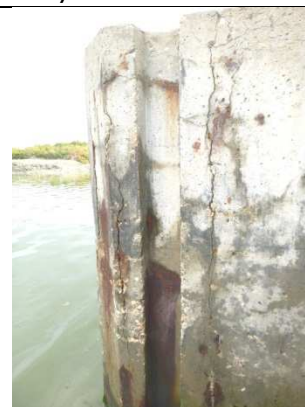
Au niveau de V3/V4 – Amorces d'éclat en tête de voile
