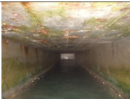
Au niveau de V9/V10 – Traces d'oxydation
