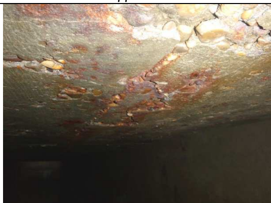
Au niveau de VII/VI2 – Traces de corrosion et ségrégations
