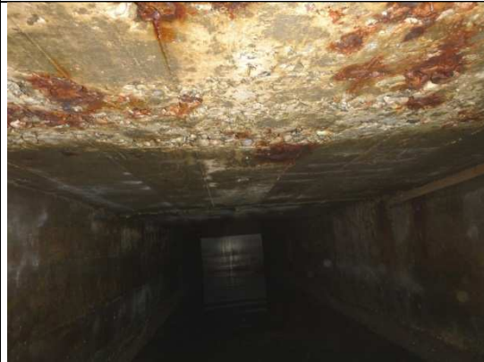
Au niveau de V6/V7 – Traces de corrosion en intrados
