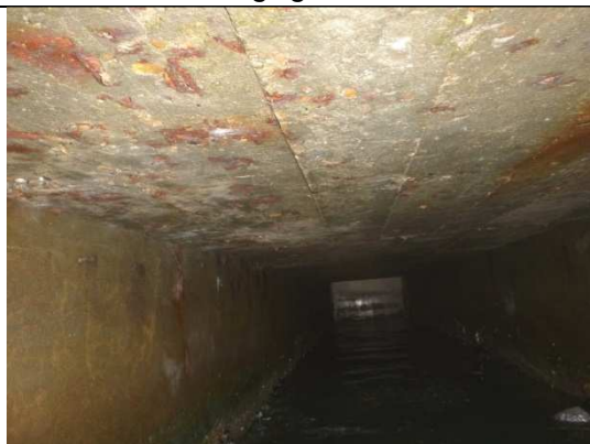
Au niveau de VII/VI2 – Traces de corrosion ponctuelles
