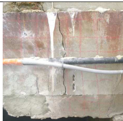
Au niveau de VII/VI2 – Fracture verticale entre 2 voiles
