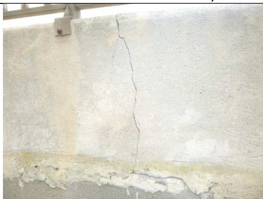
Au niveau de V7/V8 – Fissuration verticale de la retombée du tablier
