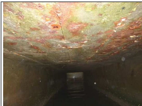
Au niveau de VI3/VI4 – Traces d'oxydation et d'humidité
