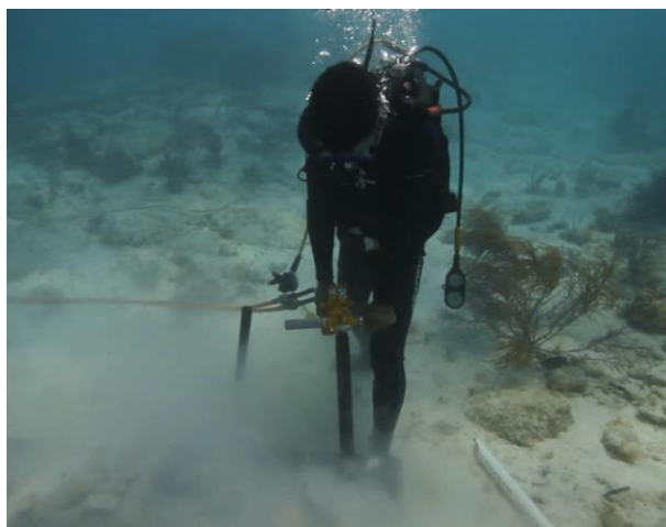
Photo 4 : Ancrage des statues
