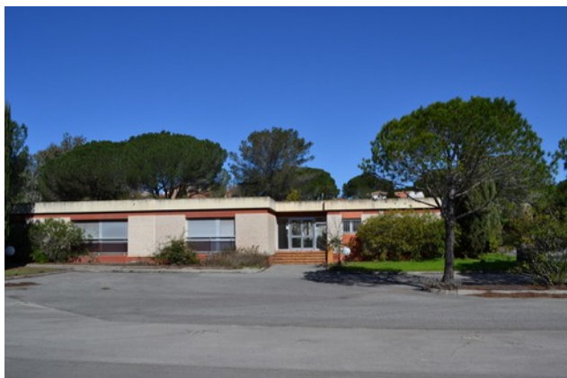
Ancienne entrée du bâtiment administratif
