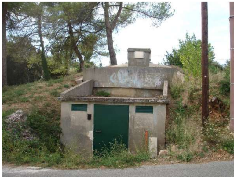
Figure 3. Le réservoir Saint Martin : le réservoir secondaire de la commune de Garéoult
