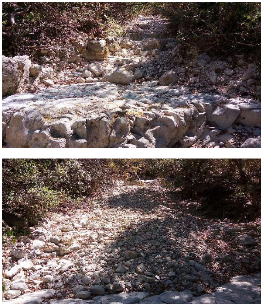
Figure 43. Photos illustrant le lit du ruisseau du Cendrier à son extrémité amont avec mise à l'affleurement du gîte du Jurassique inférieur (photo du haut) ou sédimentation colluviale récente (photo du bas)
