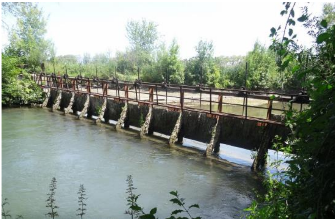
4/ Vue proche sur la partie aval du barrage (Eté 2017) – Vannes levées (Situation proche de l'état futur : les poissons pourront passer)
