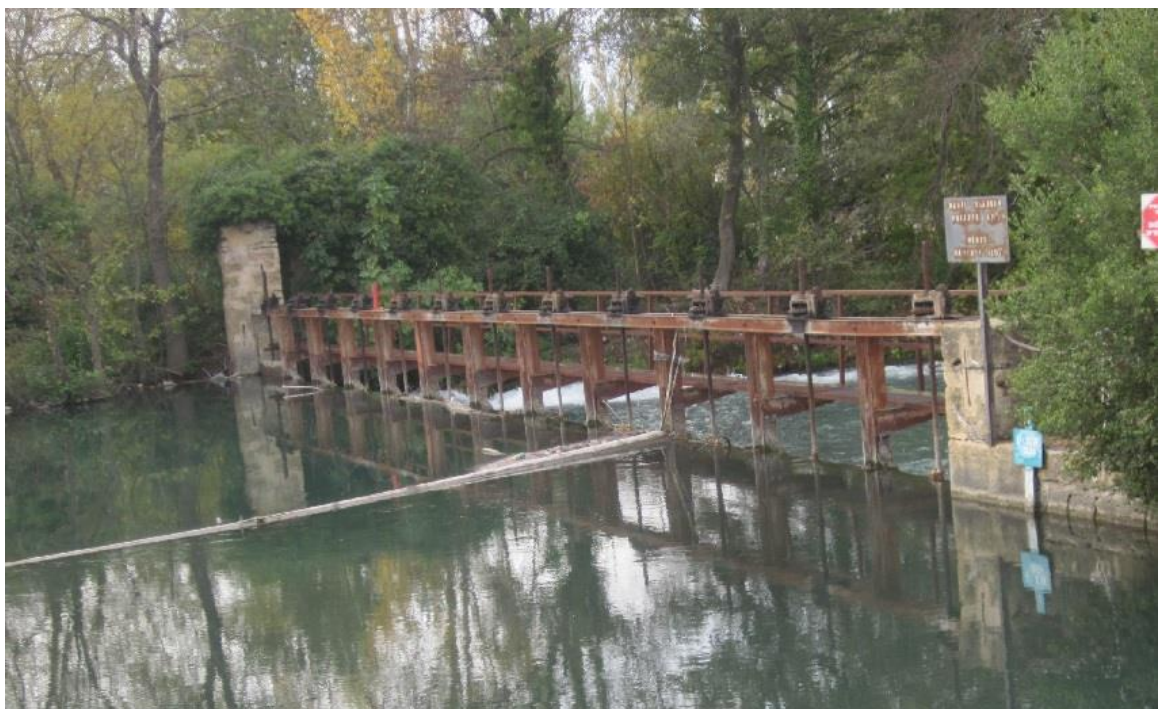
1/ Vue proche sur le barrage (à gauche) qui va être arasé et les vannes de la prise d'eau (à droite) qui vont être condamnées.
