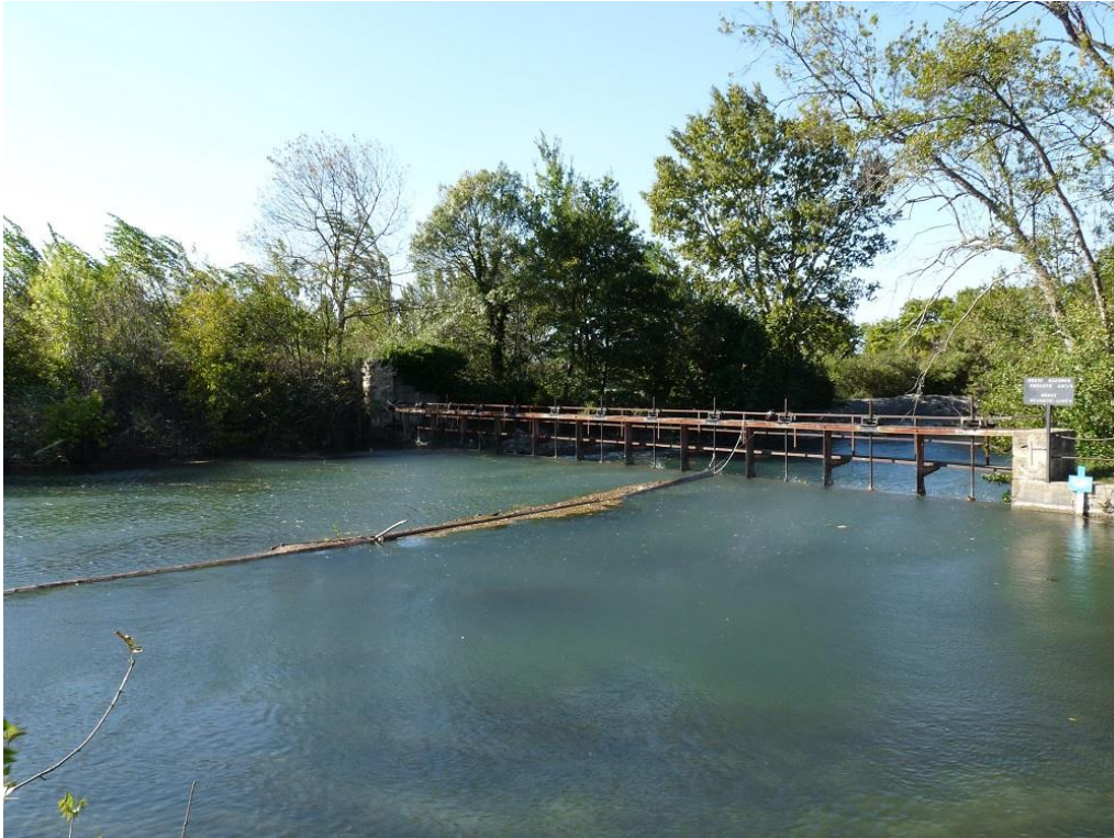
3/ Vue lointaine sur le barrage actuel (côté amont) Le projet va consister à enlever les équipements métalliques, afin de laisser passer les poissons (de l'amont vers l'aval et de l'aval vers l'amont)
