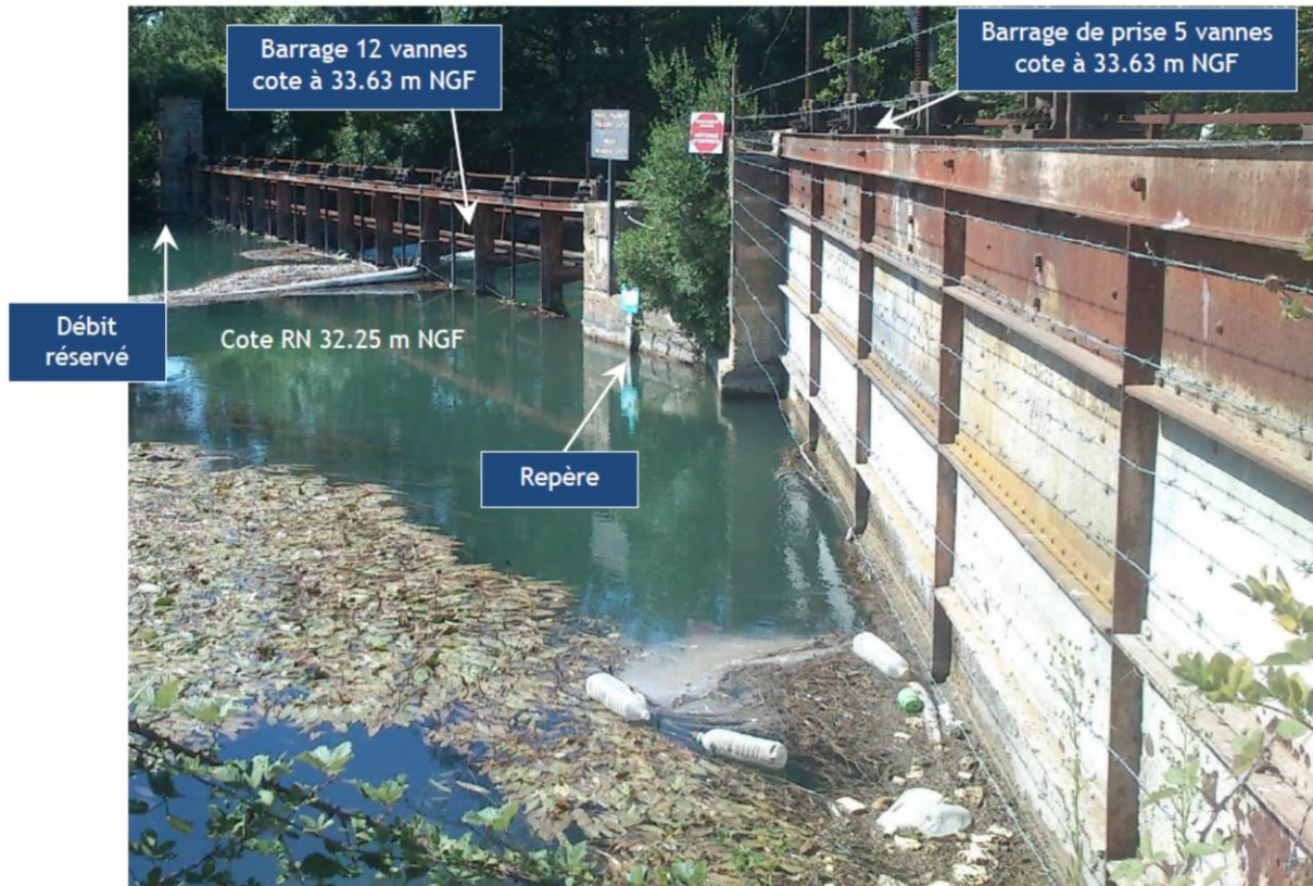
1/ Vue proche sur le barrage (à gauche) qui va être arasé et les vannes de la prise d'eau (à droite) qui vont être condamnées.
