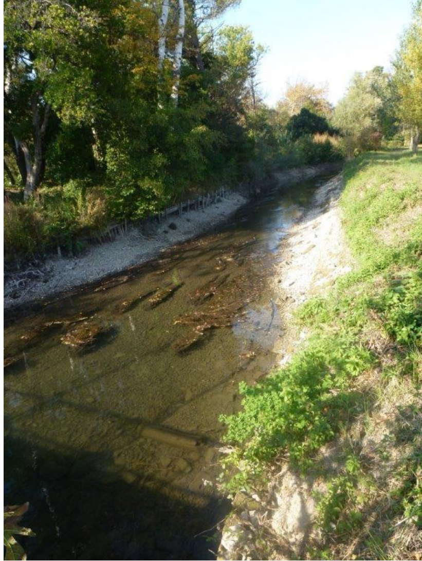
5/ Vue proche sur le canal-usinier (canal artificiel)
