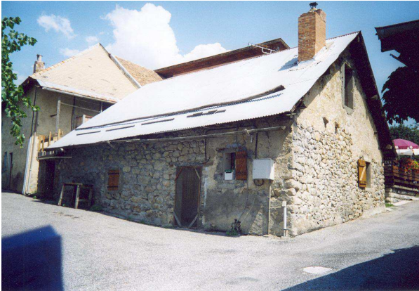
Exemple de construction dont le faîtage suit la ligne de pente
