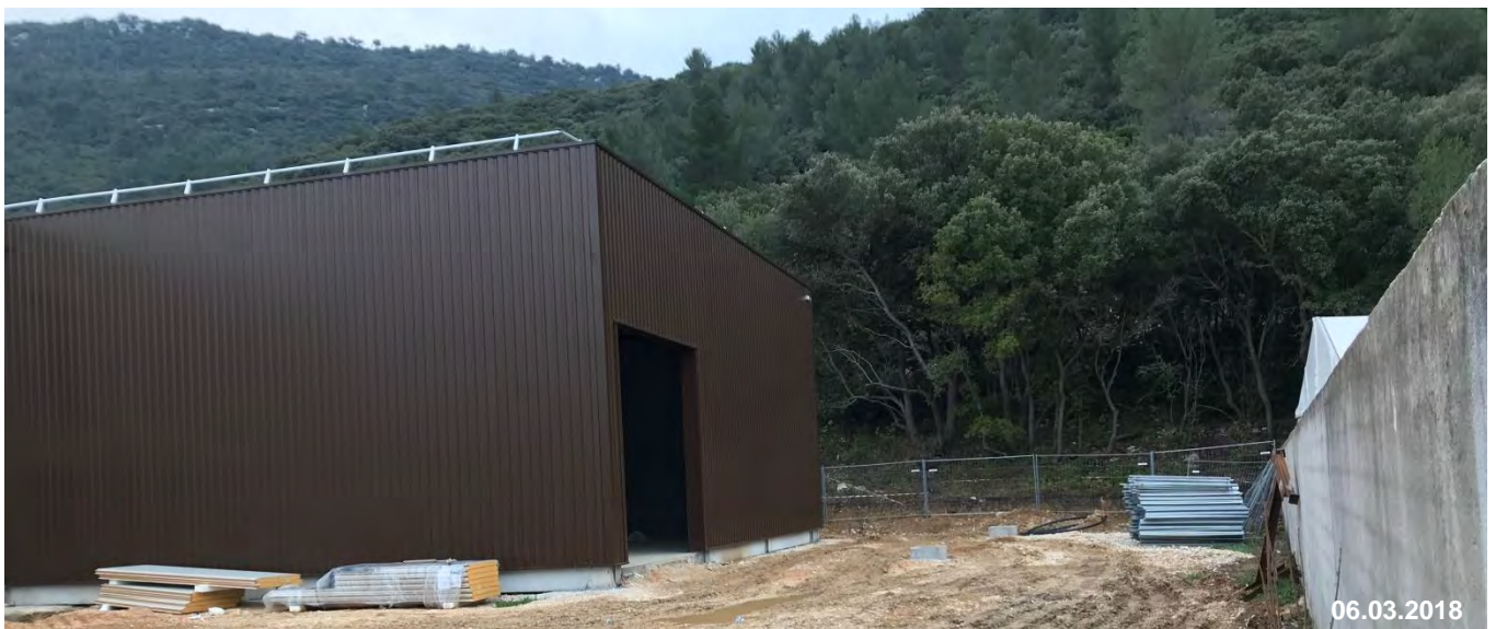
Figure 3 - DFD : Implantation du projet dans l'environnement proche : photo 1
