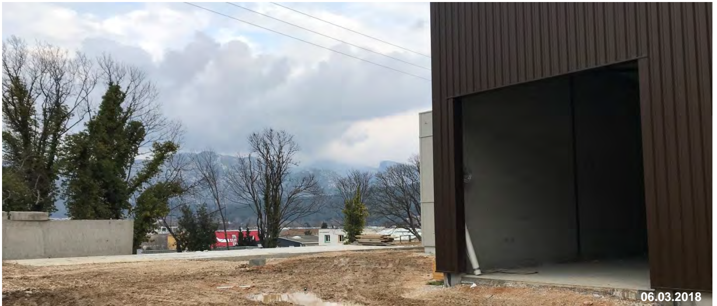
Figure 4 - DFD : Implantation du projet dans l'environnement proche : photo 2
