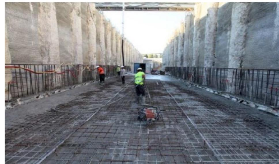
Figure 7 : Ferrailage du radier avec armatures en attente pour voiles coffrage 1 face
