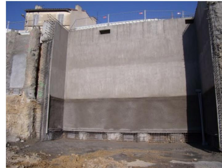
Figure 13: Voile en béton projeté non bétonné jusqu'en bas (hauteur de recouvrement) afin de permettre le montage du radier avec les armatures de recouvrement.
