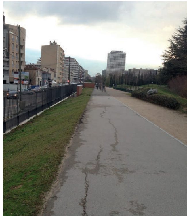
les chemins existants : enrobé et stabilisé
