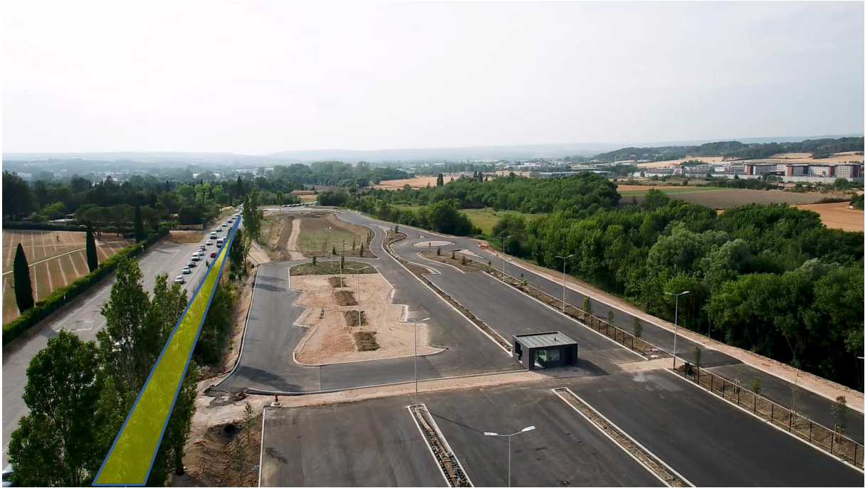
Photo : vue vers l'Ouest (impact du projet en jaune)
