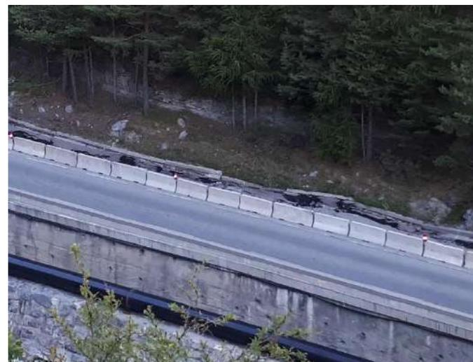
Photographie 28 : Section de la RD 947 touchée par le glissement du Pas de l'Ours
