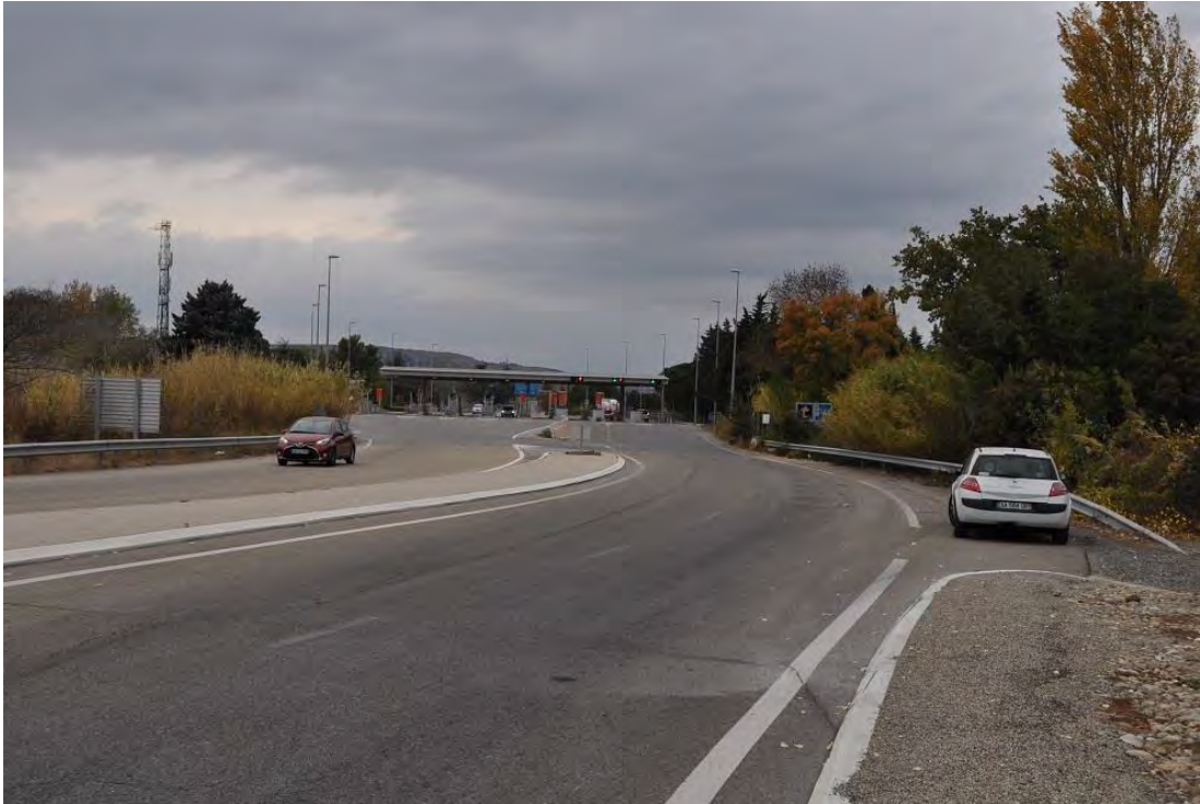
Photographie 7 : La zone d'étude est cernée à l'ouest et au sud par des infrastructures comme le témoigne l'échangeur autoroutier à l'ouest. Un linéaire boisé offre un écran visuel en limite ouest qui masque la vue depuis la route
