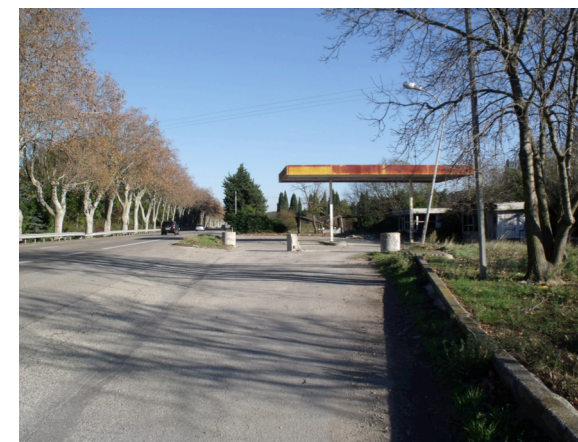
Ancienne station essence secteur « Les Saurins Sud RD7N »
