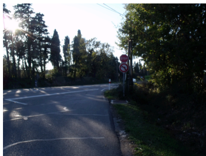
Intersection Ancienne route de Mallemort / RD7N
