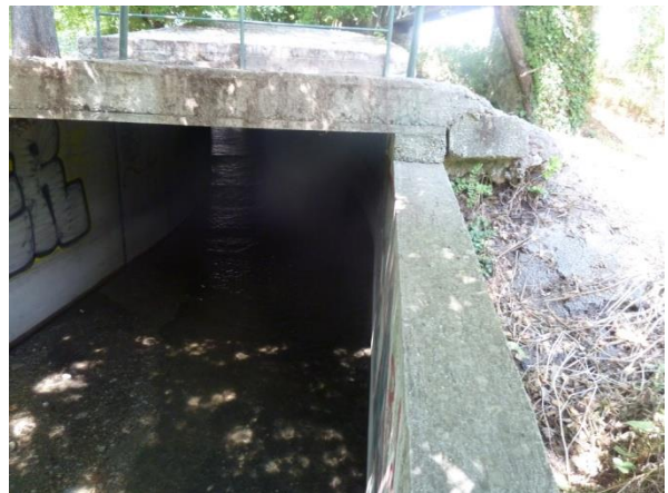
Entrée de la galerie souterraine
