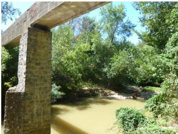
Aqueduc au niveau de la future passerelle
